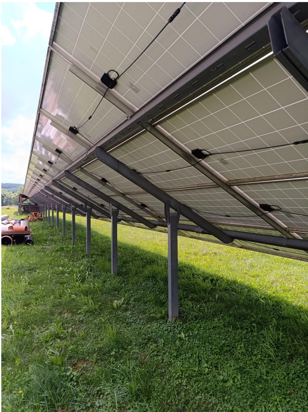
Zdjęcie nr 2- przykładowy montaż konstrukcji naziemnej
