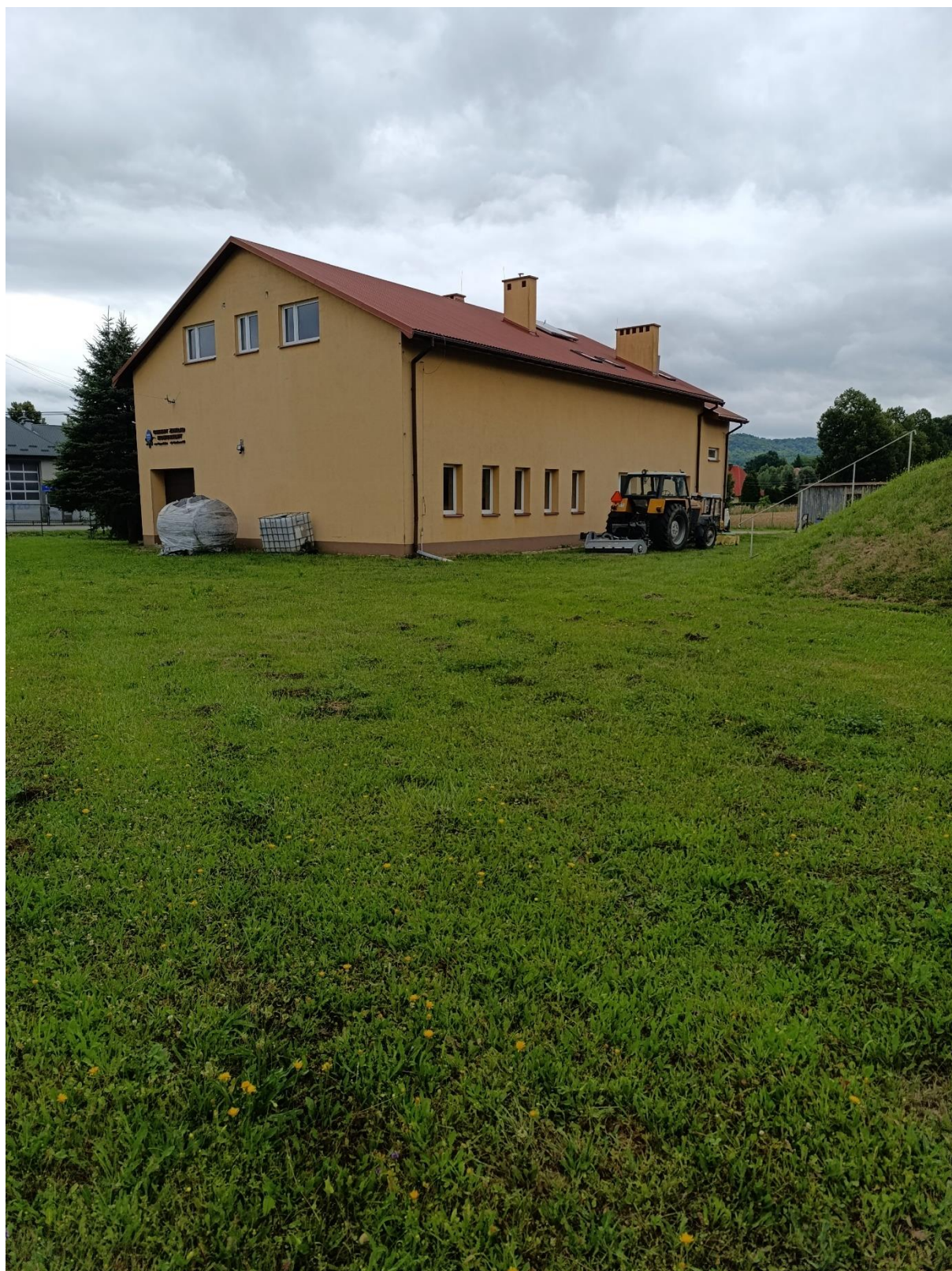
Zdjęcie nr 1 budynek SUW
