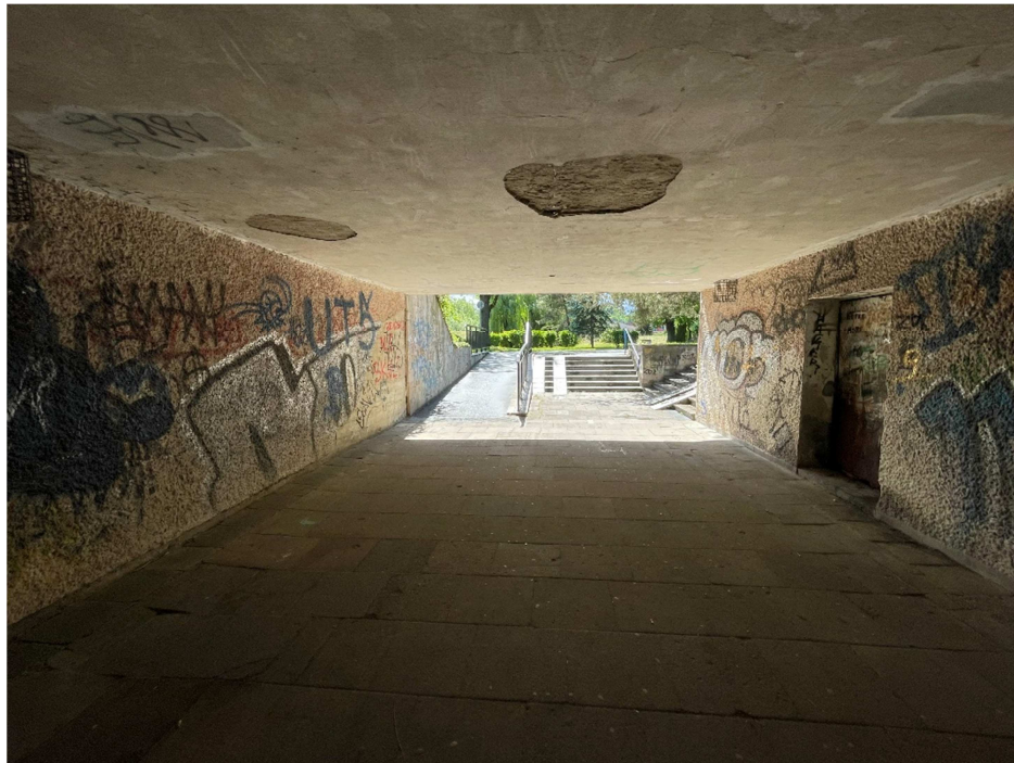
Rys. 7 Widok dojścia od strony ulicy Malczewskiego; widok na istniejącą posadzkę z płyt betonowych, posiadającą liczne spękania i nierówności; widoczne ściany boczne pokryte graffiti; Istniejący sufit posiada wykończenie gładkie cementowe, na dzień dzisiejszy widoczne wykruszenia oraz ubytki
