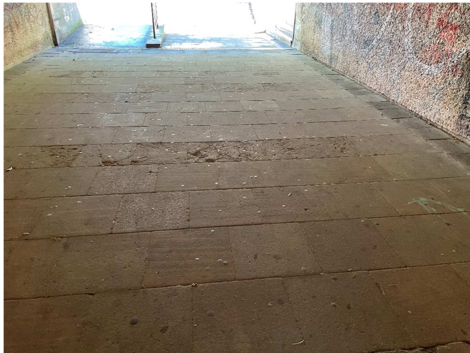
Rys. 9 Widok posadzki przejścia podziemnego, Płyty betonowe, które wg wytycznych Zamawiającego należy przeprojektować na posadzkę z płyt granitowych
