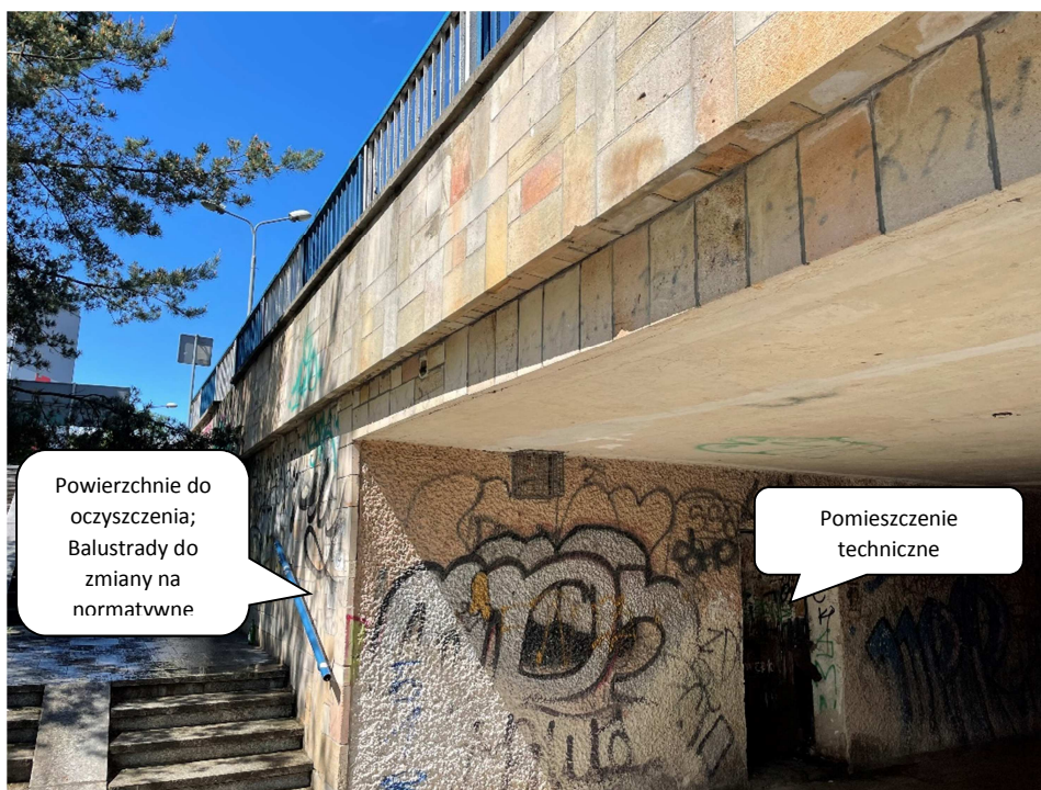
Rys. 4 Widok dojścia od strony ulicy Malczewskiego; Portal wejściowy posiada liczne grafitti i nadaje się do gruntownego oczyszczenia metodą strumieniowo-ścierną, wyspoinowania oraz zabezpieczenia hydrofobowego. Widoczne poręcze posiadają nienormatywną wysokość. Widoczna w prawym dolnym rogu wnęka zawiera pomieszczenie techniczne, które zostanie zagospodarowane zgodnie z dokumentacją techniczną.
