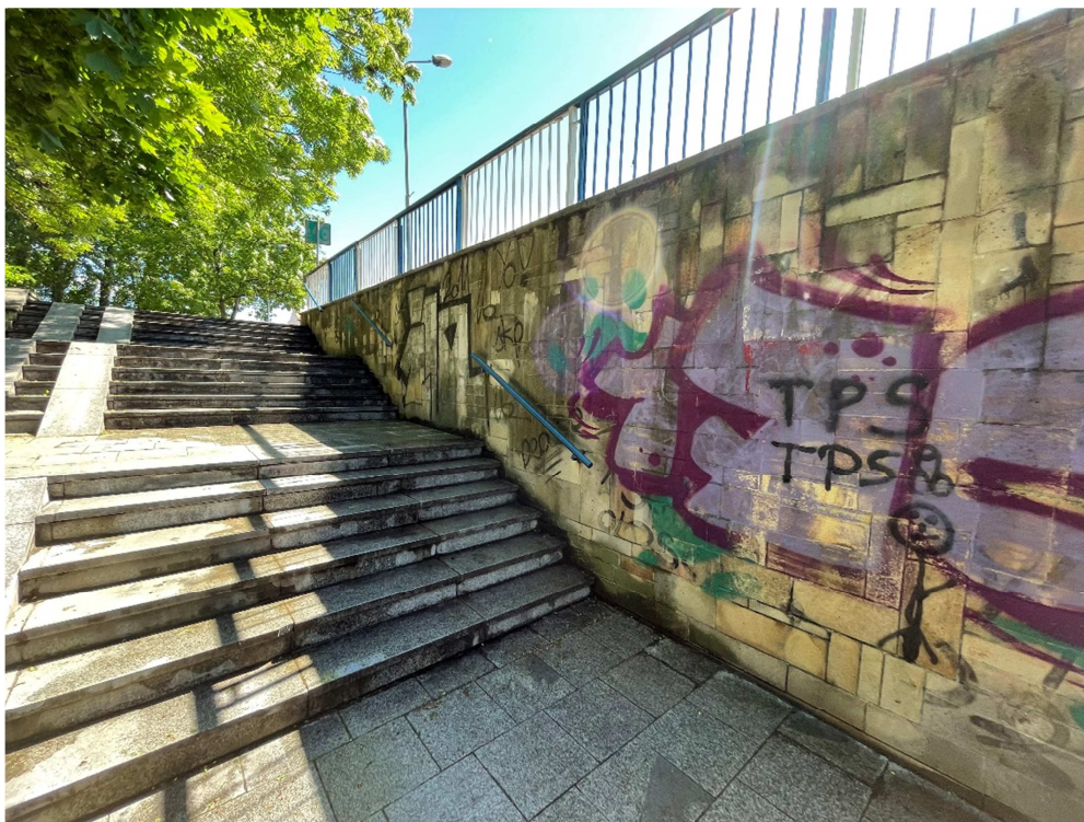
Rys. 13 Widok portalu wejściowego do przejścia podziemnego od strony ulicy Daszyńskiego; Istniejące schody w stanie dobrym do odświeżenia; Posadzka przed wejściem do wymiany na granitową;
