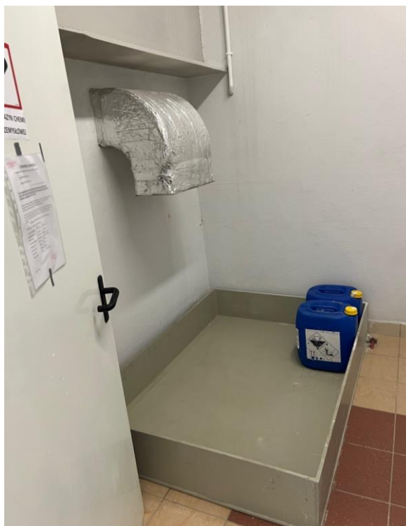
Fot. Istniejąca wanna wychwytowa na chemię basenową
