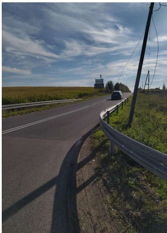
Fot. 3.6. Zniszczona krawędź jezdni i rozjeżdżone pobocza
