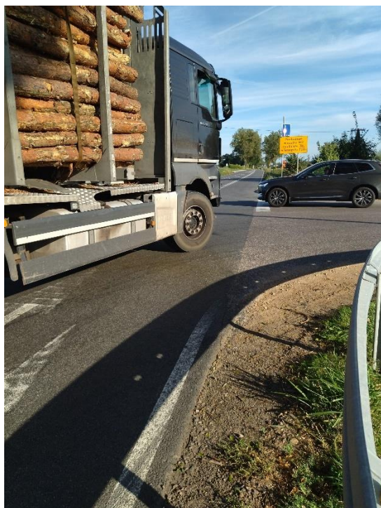
Fot. 3.8. Zniszczona krawędź jezdni i rozjeżdżone pobocza
