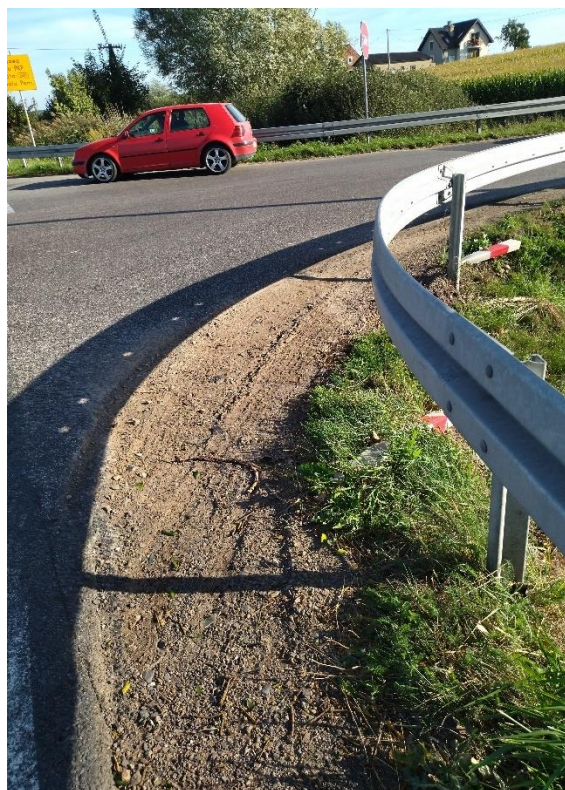
Fot. 3.7. Zniszczona krawędź jezdni i rozjeżdżone pobocza
