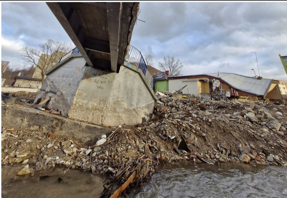
Rys. 1.2 Widok na osiadłą podporę kładki
