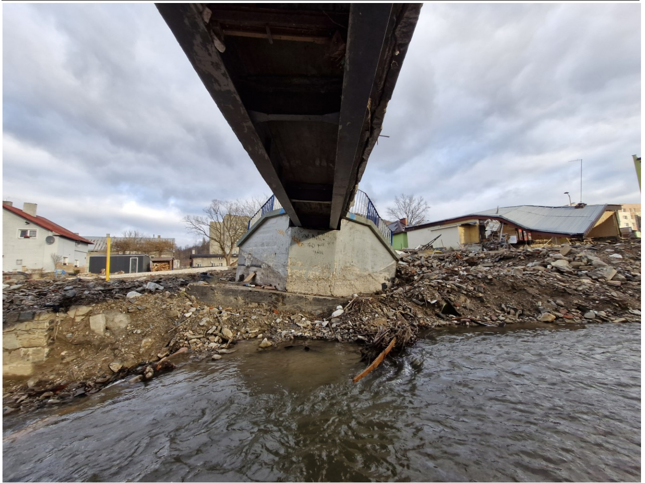
Rys. 2.2 Widok osuniętego przyczółku od strony ul. Nadbrzeżnej
