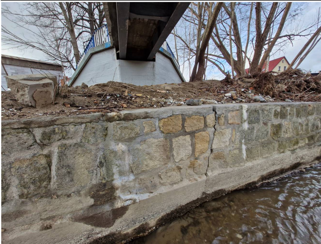
Rys. 2.3 Widok na przyczółek i uszkodzony mur oporowy od strony ul. Kościuszki
