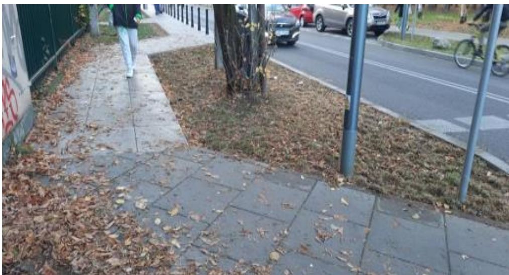
Ilustracja 19. Nawierzchnia chodnika rampowego z płyt betonowych na punktowych fundamentach w SOD
