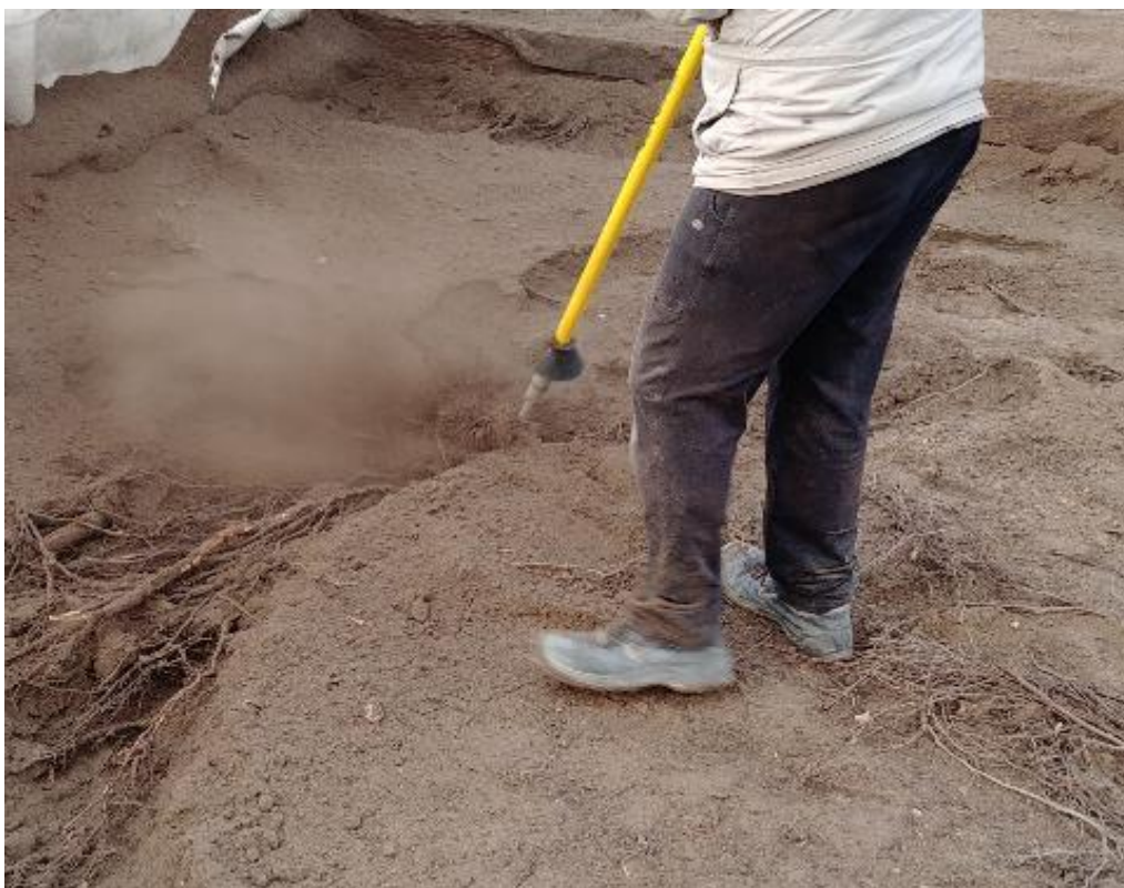
Ilustracja 9. Korytowanie pod nawierzchnie piesze z wykorzystaniem AirSpade
