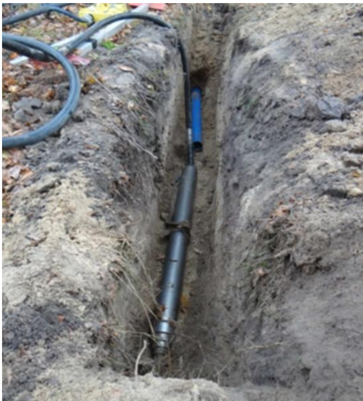
Ilustracja 35. Bezwykopowy montaż sieci w SOD
