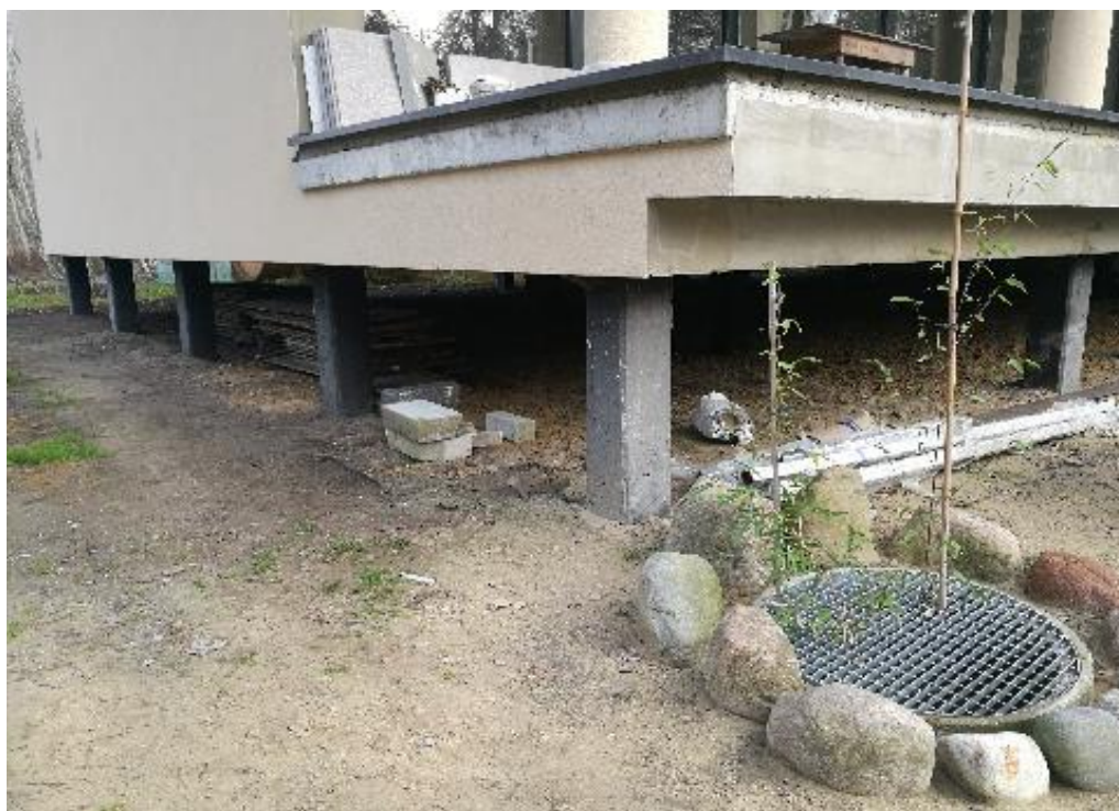
Ilustracja 12. Punktowe fundamentowanie budynku w SOD
