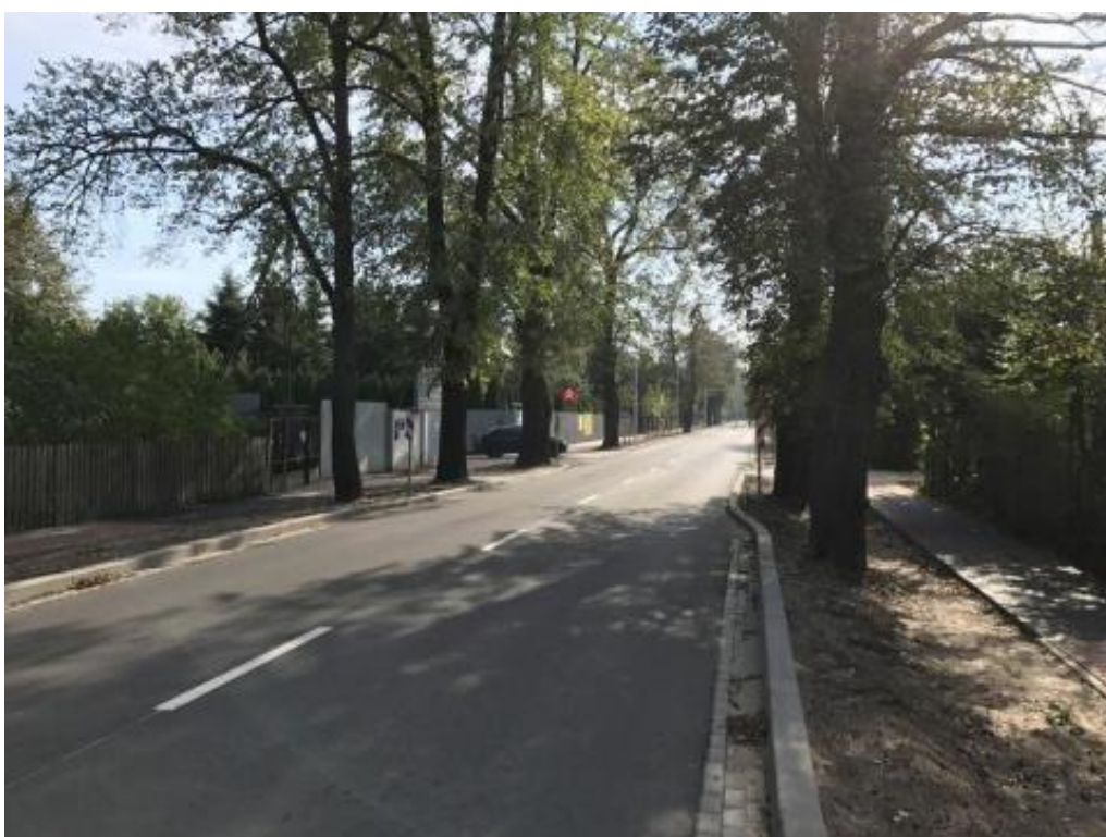
Ilustracja 25. Zwężenie drogi w SOD w celu ochrony strukturalnych korzeni drzew
