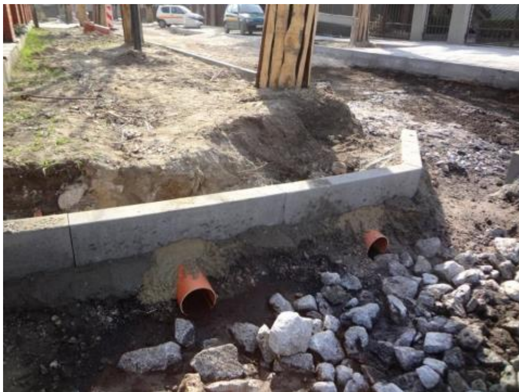
Ilustracja 21. Ścieżka korzeniowa z rury wypełnionej glebą piaszczystą
