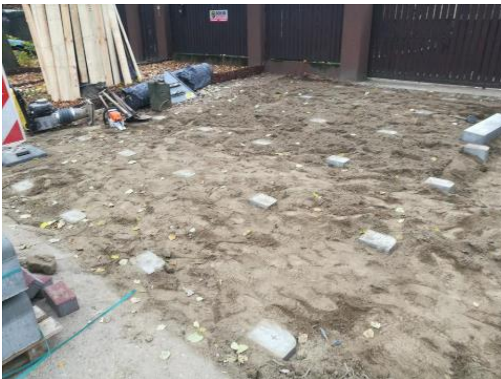
Ilustracja 13. Punktowe fundamentowanie nawierzchni pieszo-jezdných w SOD
