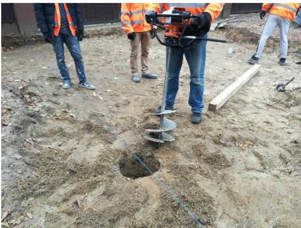
Ilustracja 14. Przygotowanie fundamentów punktowych pod nawierzchnię w SOD
