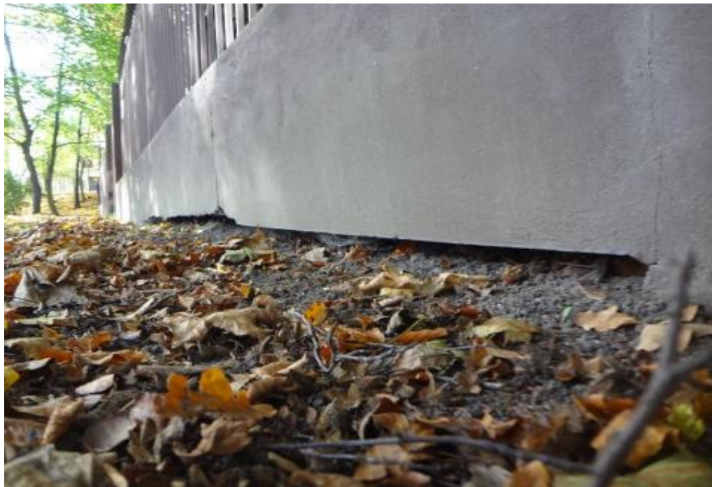
Ilustracja 11. Punktowo fundamentowe ogrodzenie w SOD – oparte na belce nad poziomem terenu
