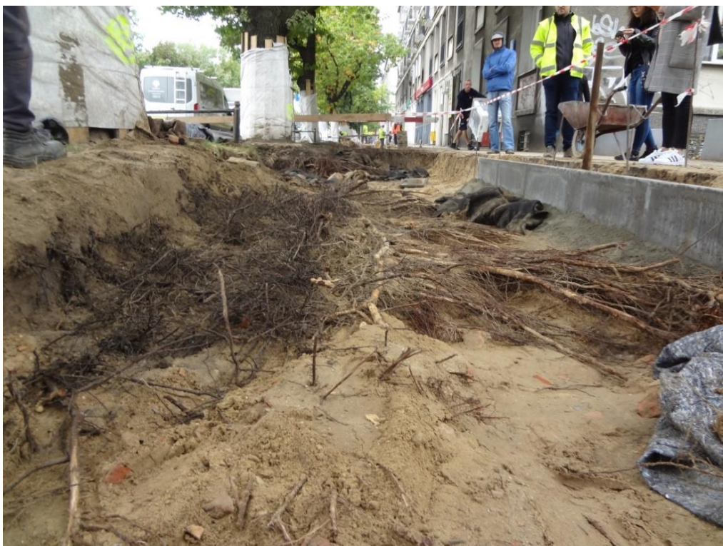
Ilustracja 10. Korytowanie pod nawierzchnie piesze z wykorzystaniem AirSpade
