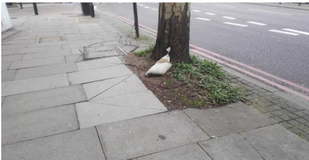
Ilustracja 30. Nawierzchnia bez obrzeża wokół misy drzewa
