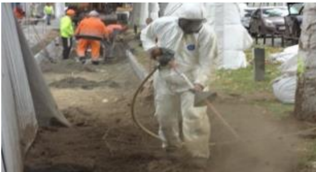
Ilustracja 40. Wydmuchiwanie gruntu sprężonym powietrzem
