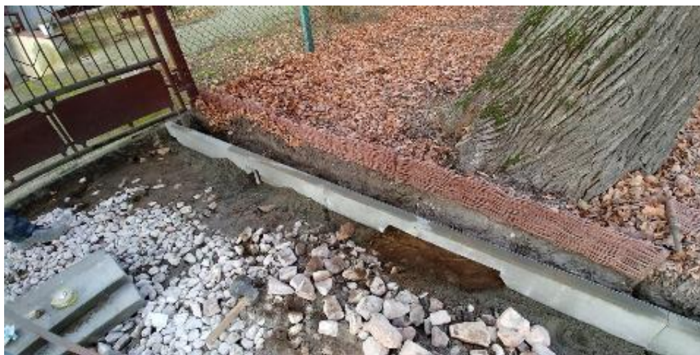
Ilustracja 27. Krawężnik mostowy zamontowany nad korzeniami drzewa
