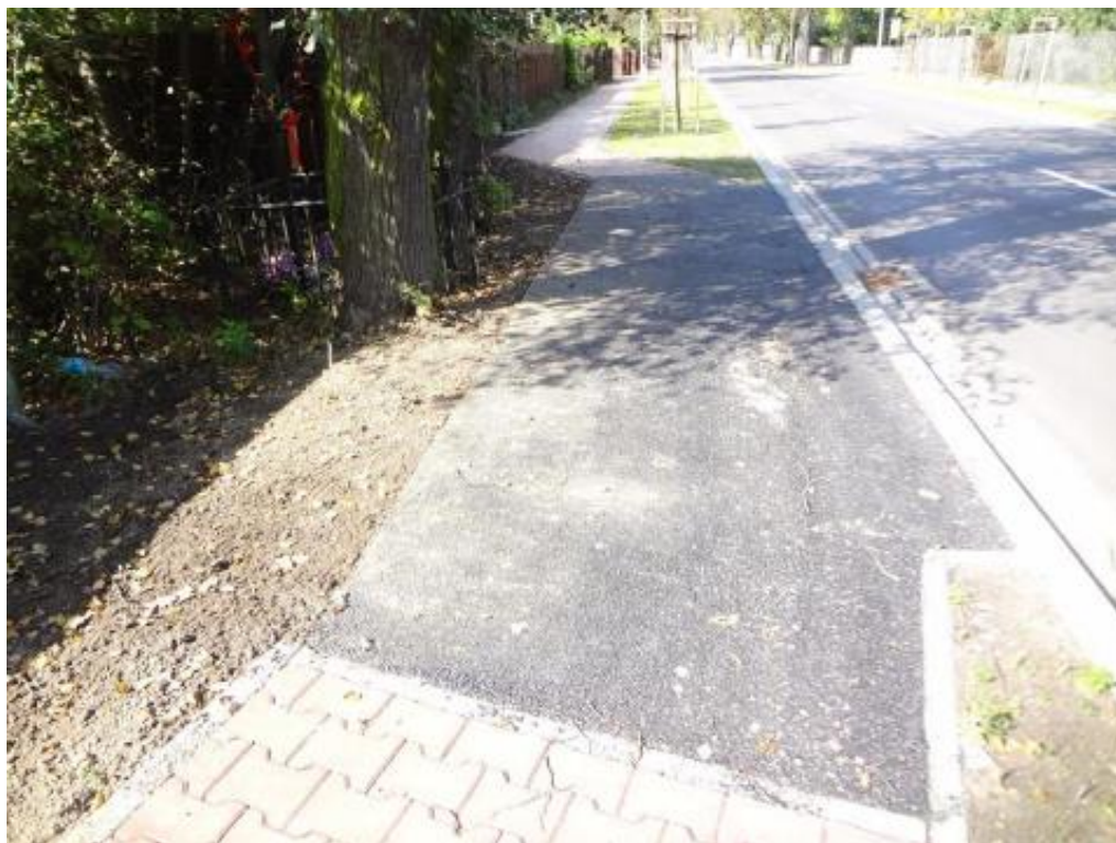
Ilustracja 26. Płytkie krawężniki typu eko-bord w SOD
