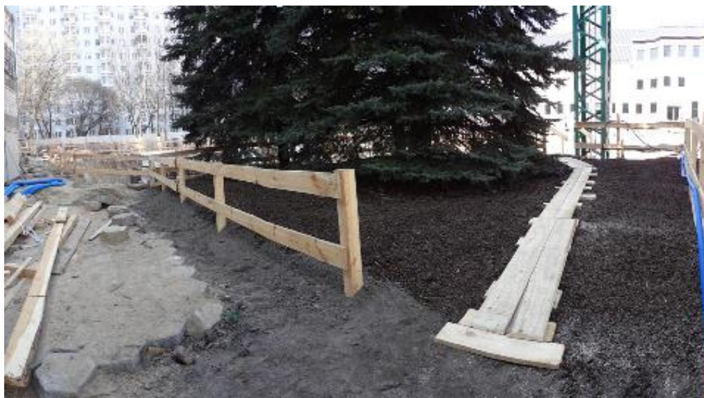
Ilustracja 39. Tymczasowe ogrodzenie ochronne SOD, widoczne również ochronne ściółkowanie wewnątrz ogrodzenia
