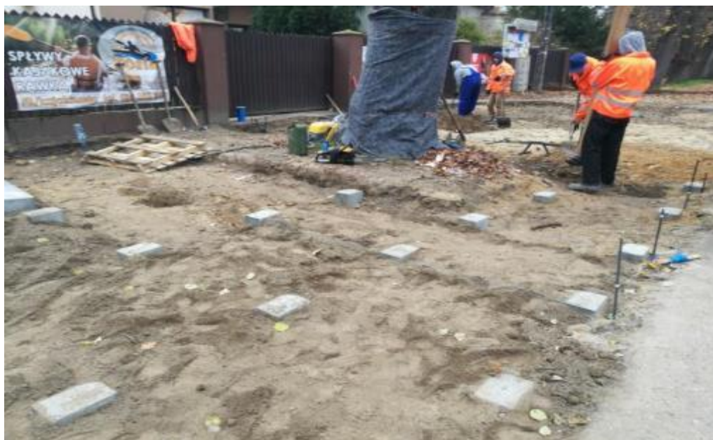
Ilustracja 17. Przygotowanie podbudowy (fundamentów) chodnika rampowego w SOD
