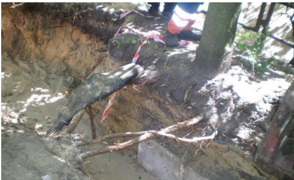
Ilustracja 36. Prace w otwartym wykopie w SOD z pozostawieniem korzeni o średnicy powyżej 3 cm
