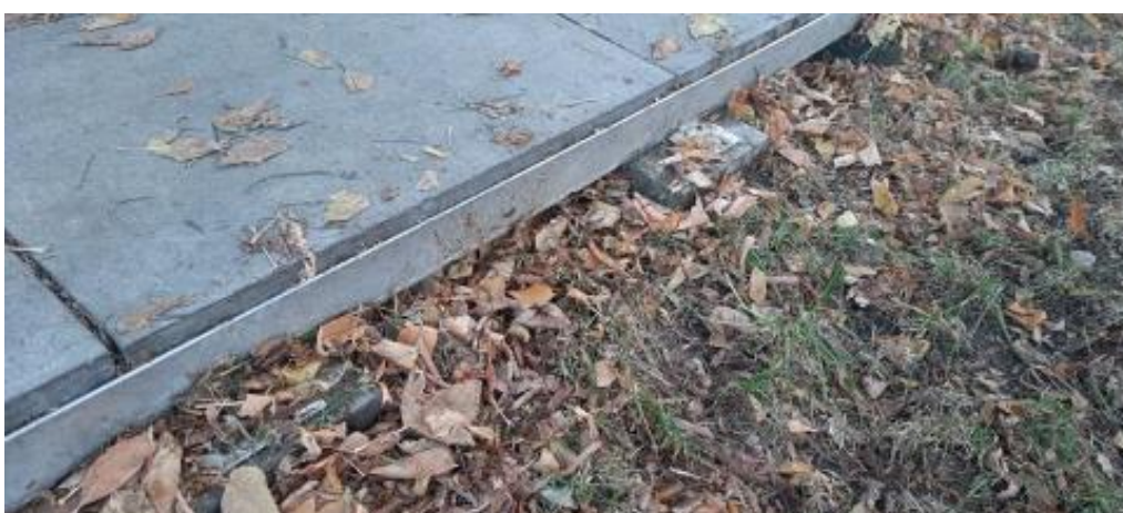
Ilustracja 32. Listwa kotwiona na punktowych fundamentach
