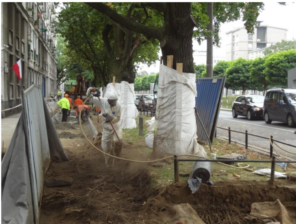
Ilustracja 15. Korytowanie pod podbudowę mieszanki kamienno-glebowej w SOD
