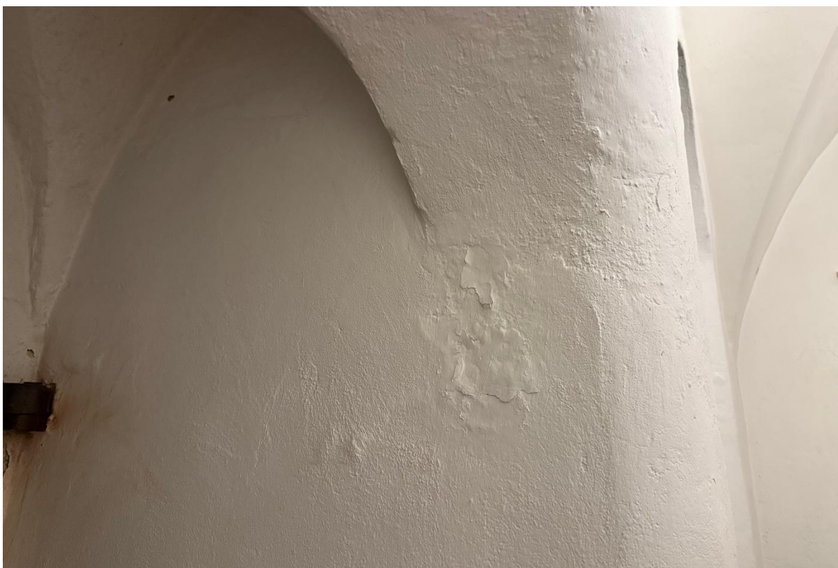
fot. 58 Spęcherzenia wtórnych warstw technologicznych.
