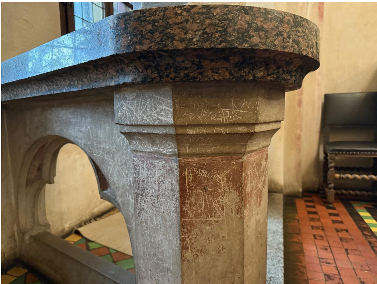
fot. 55 Uszkodzenia warstw malarskich na elemencie kamiennym – izba skarbnika.
