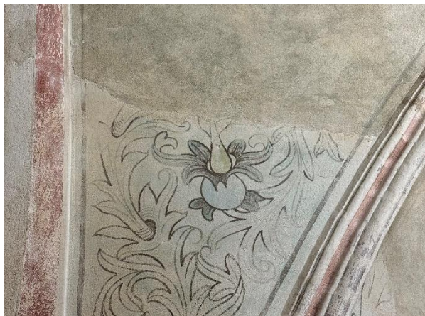
fot. 53 Uszkodzenia warstw malarskich w izbie skarbnika.
