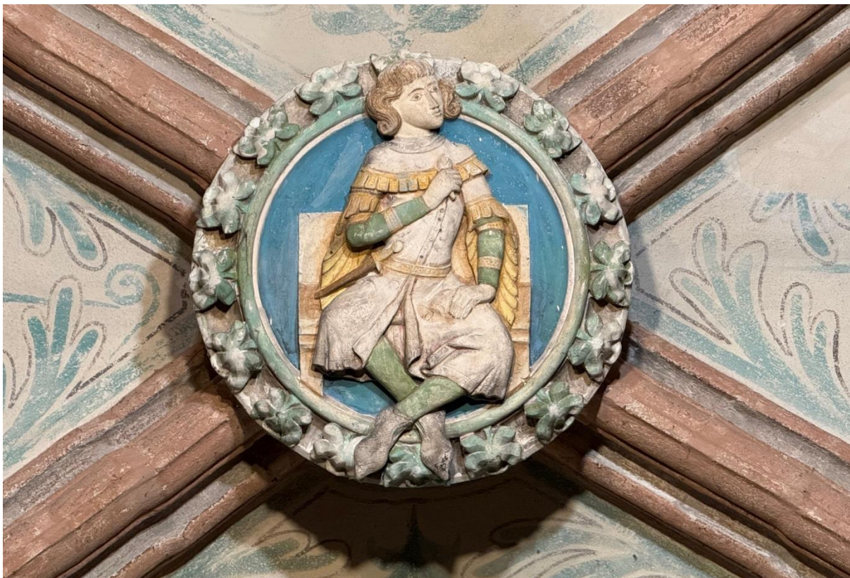
fot. 81 Zwornik sklepienny.
