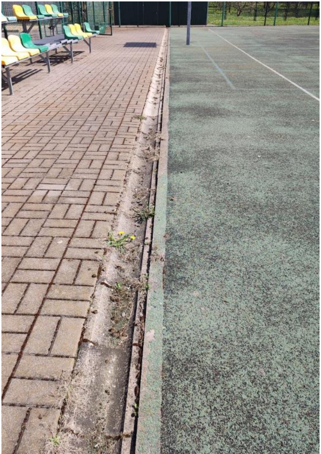
Rysunek 5. Odwodnienie liniowe boiska
