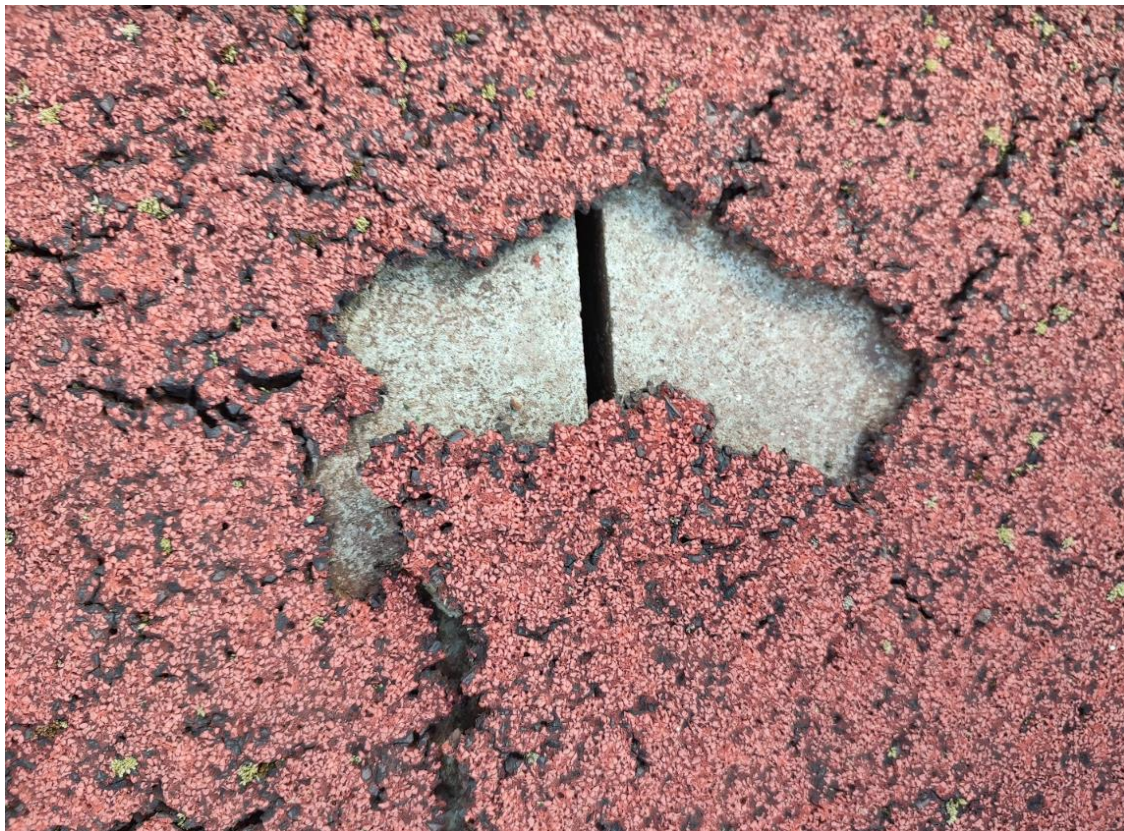
Rysunek 1. Dylatacje płyty boiska
