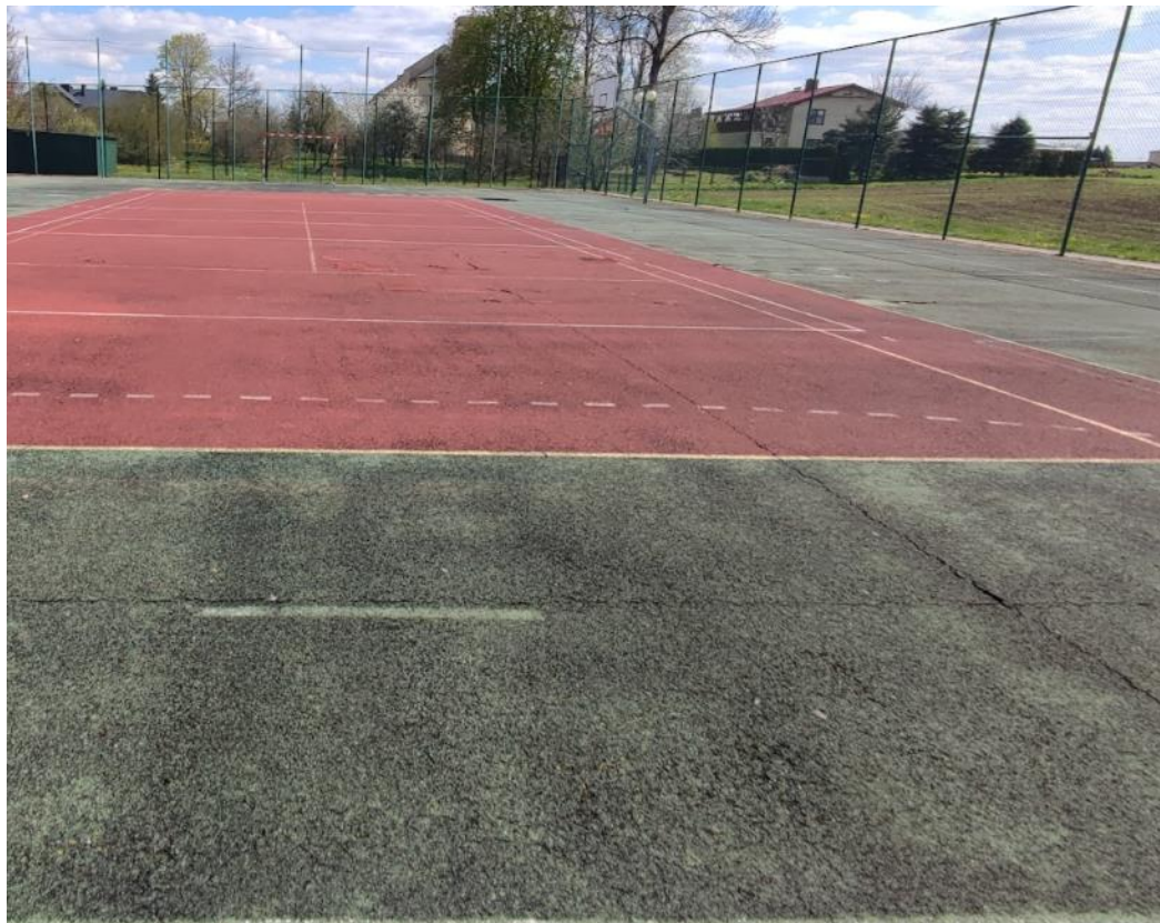
Rysunek 3. Uszkodzenia wzdłuż krawędzi dylatacji płyty betonowej
