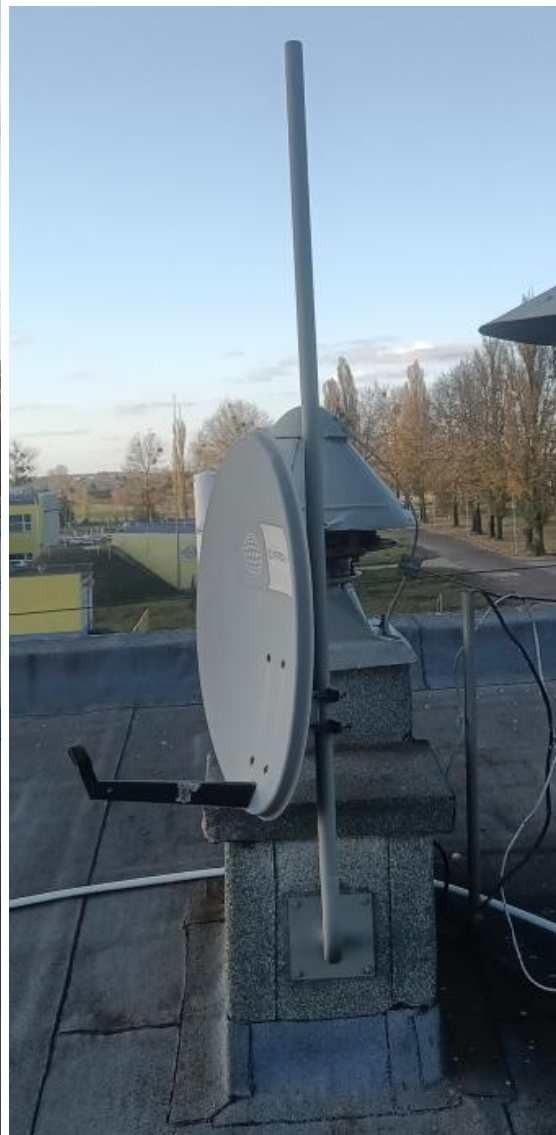
Rysunek 5 - brak podpięcia instalacji odgromowej do masztu antenowego z wprowadzonymi przewodami do wnętrza budynku
