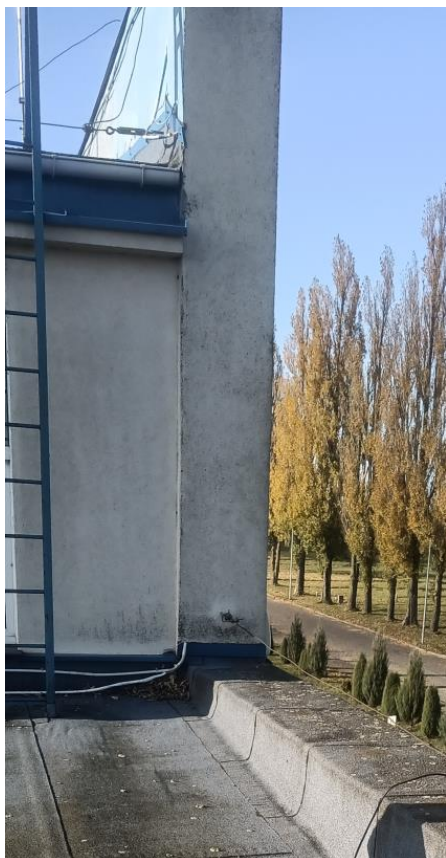
Rysunek 2 – Połączenie instalacji odgromowych tylko na ścianach frontowych budynku, brak połączeń instalacji odgromowej w dalszym ciągu budynku
