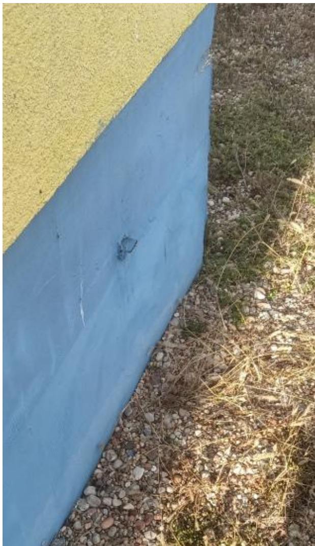
Rysunek 6 - ucięte płaskowniki uziemiające na kioskach i przy budynku koagulacji
