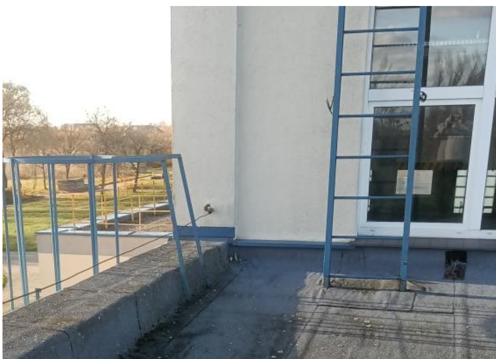
Rysunek 4 - drabiny nie podpięte do instalacji odgromowej
