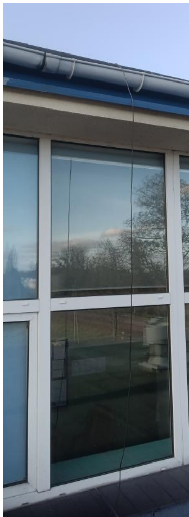
Rysunek 3 - luźne przewody na dachu wprowadzone do budynku
