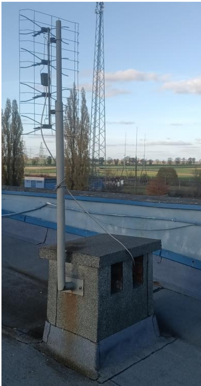
Rysunek 5 - brak podpięcia instalacji odgromowej do masztu antenowego z wprowadzonymi przewodami do wnętrza budynku
