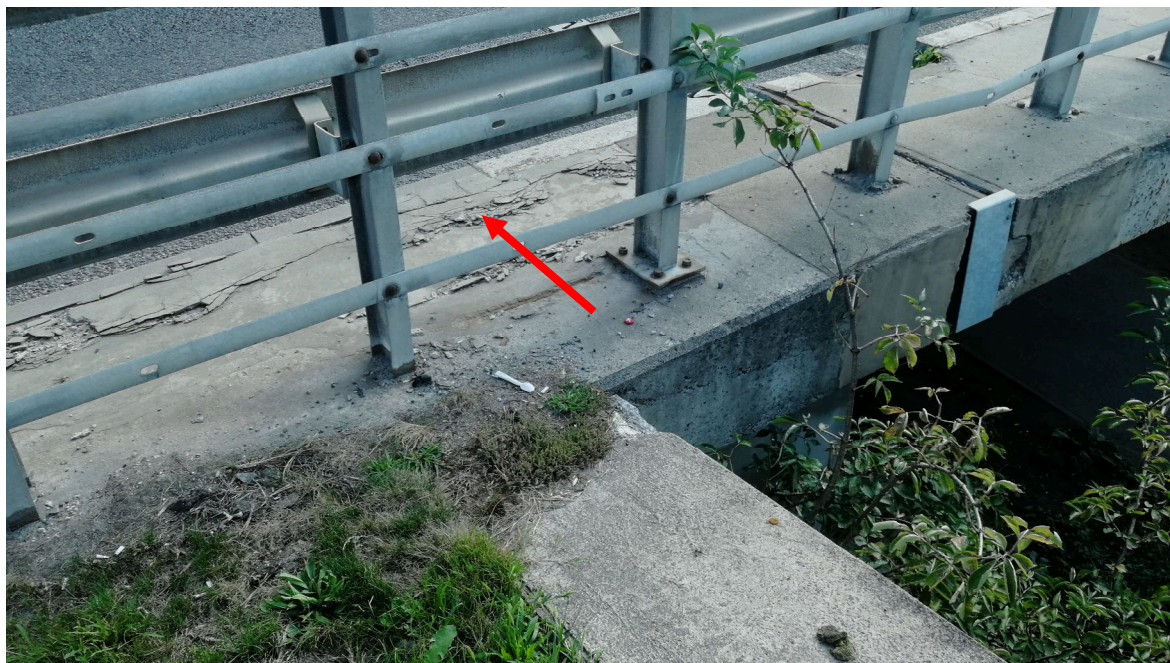
Rys. 4.20. Kapa w obszarze przyczółka 14S, widok od strony pasa rozdziału. Widoczne odspojenia betonu, zaawansowana korozja betonu kapy.
