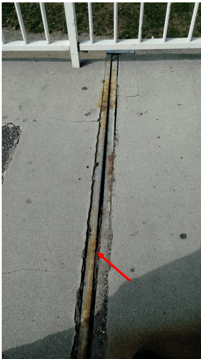
Rys. 5.18. Urządzenie dylatacyjne w obszarze chodnika. Przesło skrajne od strony centrum Jeleniej Góry (przyczółek P1N). Widoczne całkowicie zamknięte urządzenie dylatacyjne. Brak możliwości realizowania przesuwów w kierunku przyczółka 1N. Zalegające zanieczyszczenia, korozja profilu dylatacyjnego.
