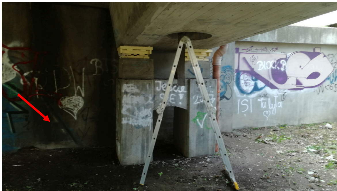
Rys. 4.2. Widok strefy oparcia dźwigara wewnętrznego na przyczółku P1S. Widocznie zacieki i zanieczyszczenie powierzchni.
