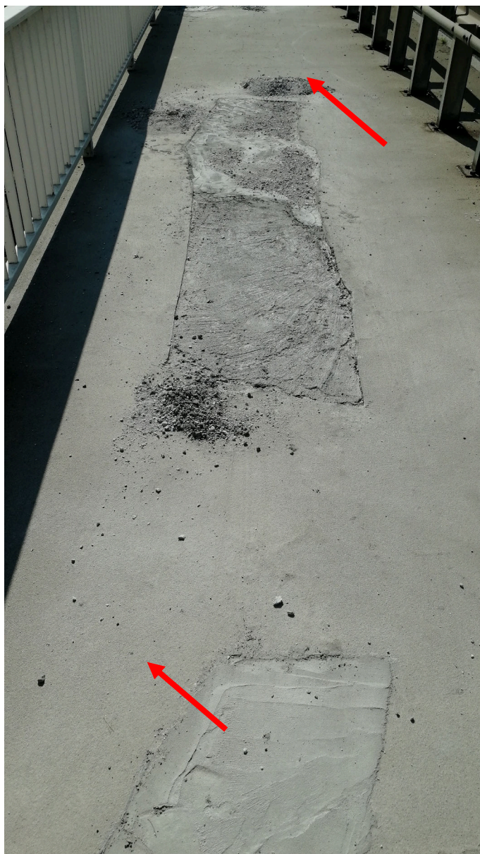
Rys. 4.22. Kapa chodnikowa. Widoczne ślady napraw lokalnych nawierzchni, wykruszenia betonu.
