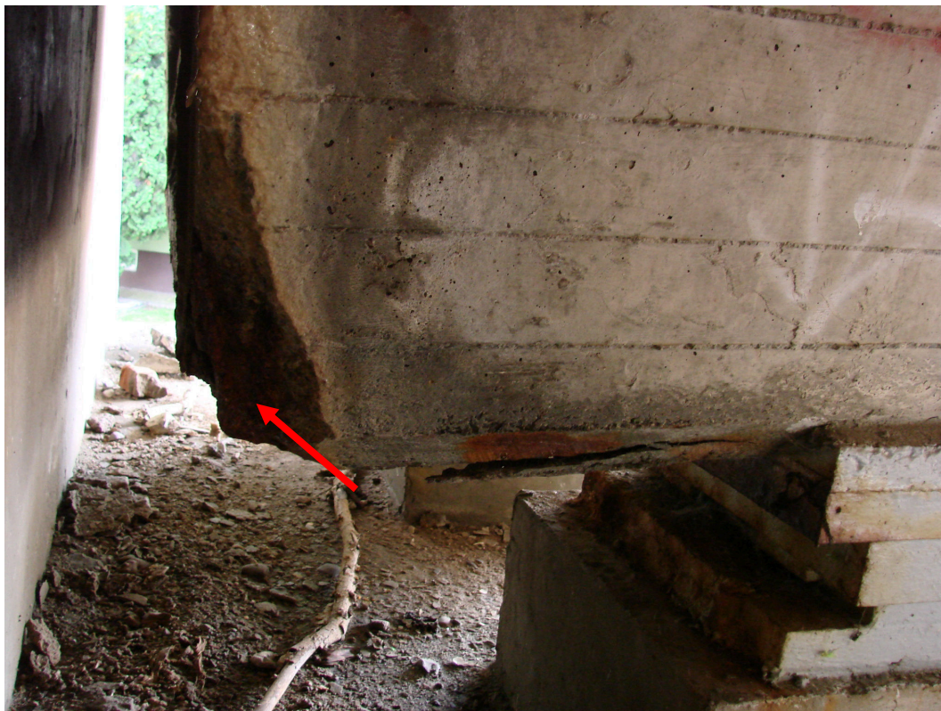
Rys. 4.11. Belka zewnętrzna przęsła skrajnego, widok w strefie oparcia na przy- czółku 14S. Uszkodzenie krawędziowe, odspojenia betonu.
