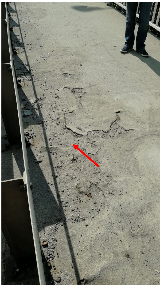
Rys. 5.22. Kapa chodnikowa. Widoczne spękania nawierzchni oraz jej wykruszenia, globalny charakter uszkodzeń.
