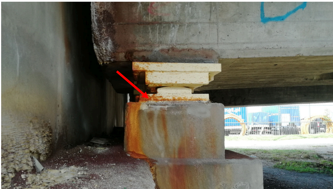
Rys. 5.6. Widok ogólny łożysk na przyczółku P1N, strefa oparcia dźwigara południowego. Ogniska korozji powierzchniowej.
