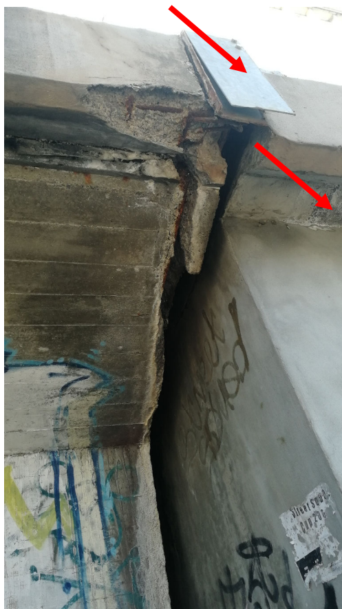
Rys. 5.4. Widok strefy urządzenia dylatacyjnego oraz belki gzymsowej; przyczółek P1N. Widocznie lokalne ubytki betonu pod belką gzymsową (po stronie podpory). Uszkodzenia mocowania przesłony urządzenia dylatacyjnego.
