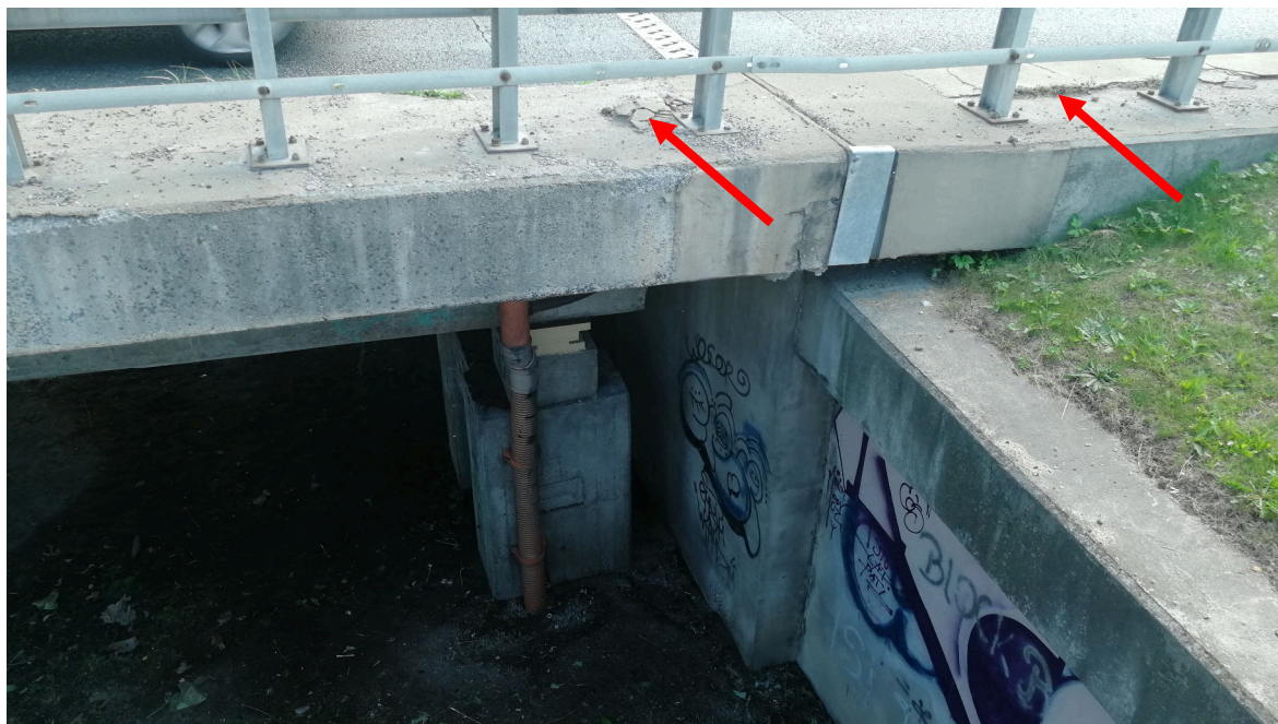
Rys. 5.19. Kapa w obszarze przyczółka P1N, widok od strony pasa rozdziału. Wi-doczne odspojenia betonu, zaawansowana korozja betonu kapy po stronie przęsła skrajnego oraz przyczółka.
