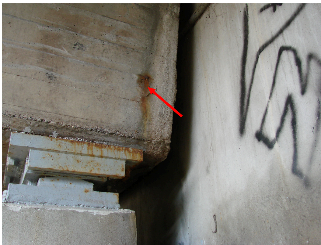
Rys. 5.8. Belka zewnętrzna przęsła skrajnego, widok w strefie oparcia na przyczółku 14N. Zawilgocenie zakończenia belek, rdzawe zacieki świadczące o korozji zbrojenia, nacieki węgla wapnia.
