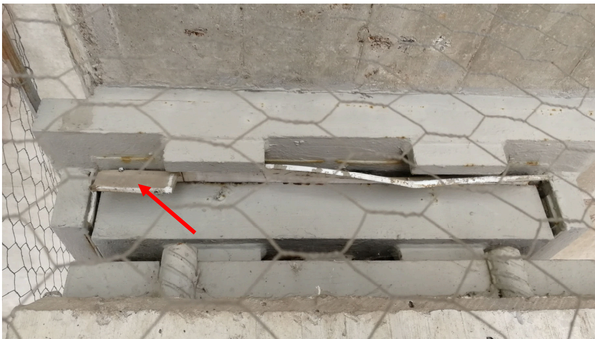
Rys. 5.7. Widok ogólny łożyska na filarze P13N, widoczne wysunięcie płyty ślizgowej .
