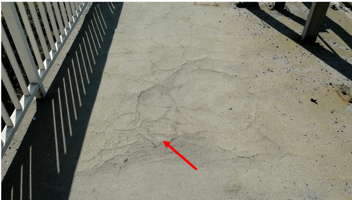
Rys. 4.23. Kapa chodnikowa. Widoczne spękania nawierzchni oraz jej podniesienie świadczące o zaawansowanej korozji wgłębnej betonu kapy.
