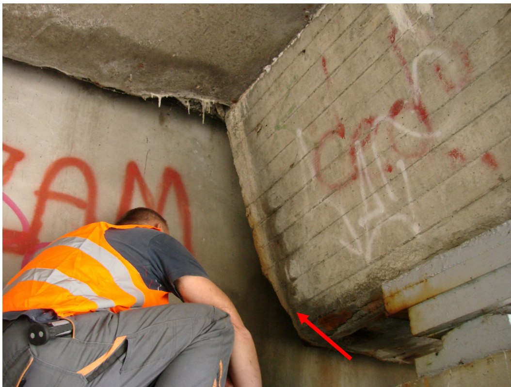
Rys. 4.8. Belka zewnętrzna przęsła skrajnego, widok w strefie oparcia na przyczółku 14S. Zawilgocenie zakończenia belek, zaawansowana korozja betonu, odsłonięcia, nacieki węglanu wapnia.
