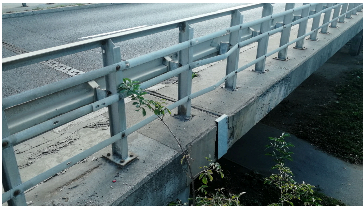
Rys. 4.27. Barieroporęcz, przęsło skrajne od strony Zabobrza. Widoczne deformacje elementów bariery, spowodowane brakiem swobody przemieszczeń na styku przęsło/przyczółek.
