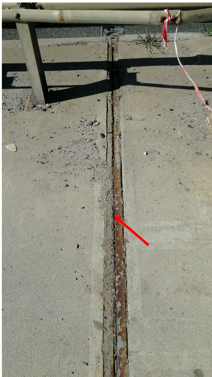
Rys. 4.19. Urządzenie dylatacyjne w obszarze chodnika. Przesło skrajne od strony centrum Jeleniej Góry (przyczółek P1S). Widoczne całkowicie zamknięte urządzenie dylatacyjne. Brak możliwości realizowania przesuwów w kierunku przyczółka 1S. Zalegające zanieczyszczenia, wegetacja roślin, korozja profilu dylatacyjnego.
