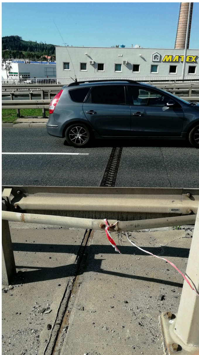
Rys. 4.28. Bariera ochronna, przeszło skrajne od strony centrum Jeleniej Góry. Widoczne deformacje elementów bariery, spowodowane brakiem swobody przemieszczeń na styku przeszło/przyczółek.
