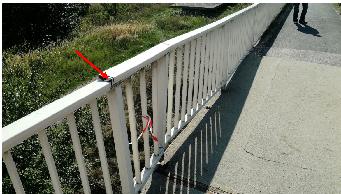
Rys. 4.26. Balustrada przy chodniku, przęsło skrajne od strony centrum Jeleniej Góry. Widoczne deformacje elementów balustrady, spowodowane brakiem swobody przemieszczeń na styku przęsło/przyczółek.
