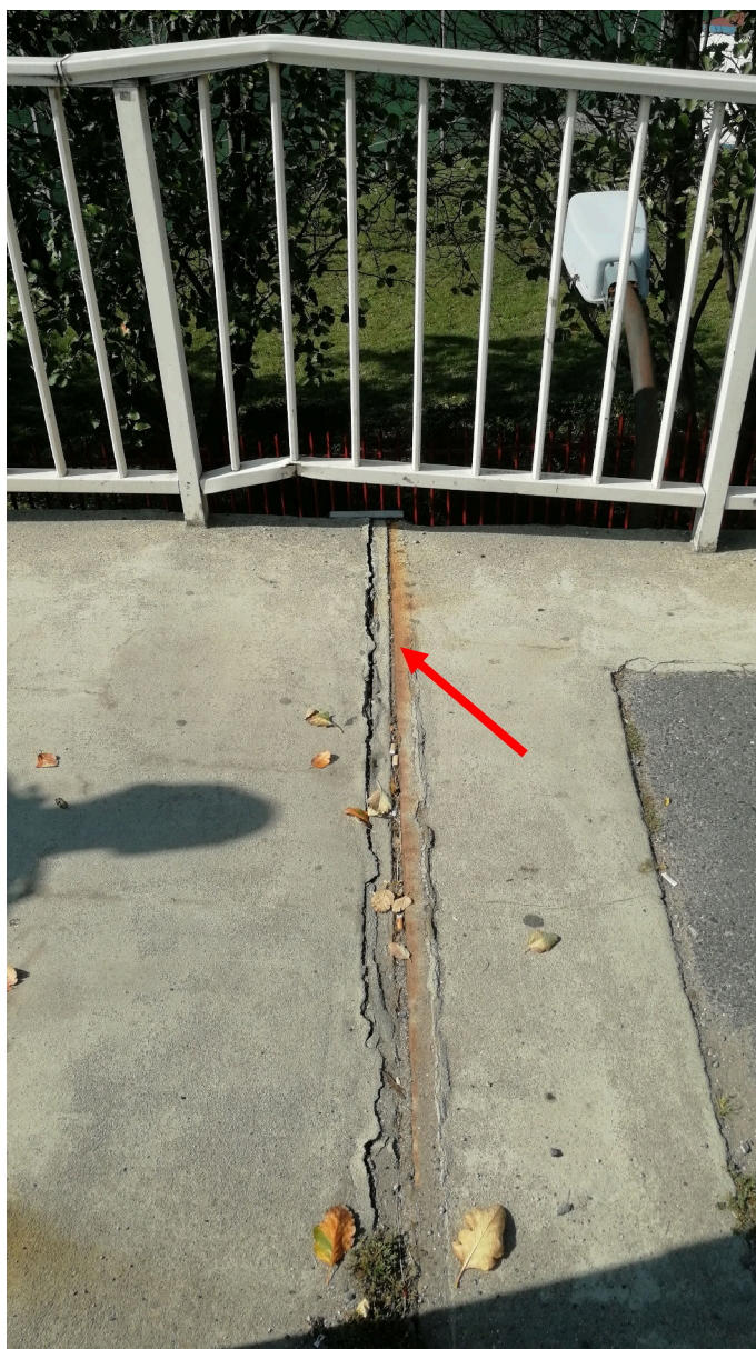
Rys. 5.16. Urządzenie dylatacyjne w obszarze chodnika. Przeszło skrajne od strony Zabobrza (przyczółek P14N). Widoczne całkowite zamknięcie urządzenia dylatacyjne. Brak możliwości realizowania przesuwów w kierunku przyczółka 14S. Zalegające zanieczyszczenia, wegetacja roślin.
