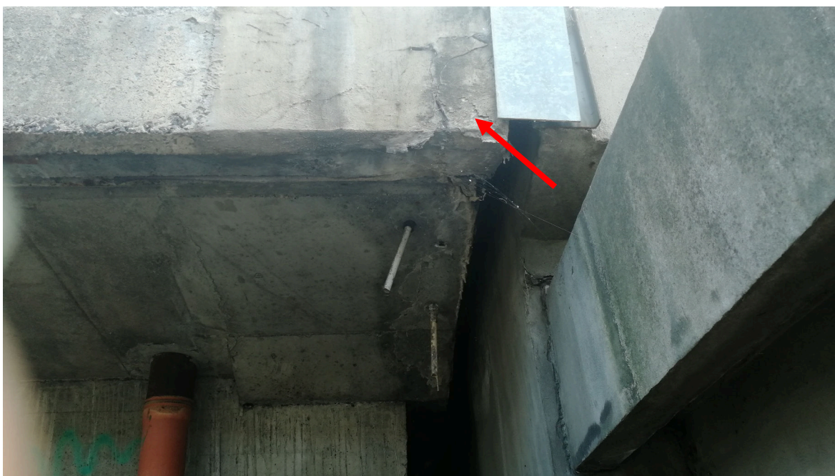
Rys. 4.25. Belka gzymsowa, przyczółek P14S. Widoczne ubytki oraz odspojenia betonu.
