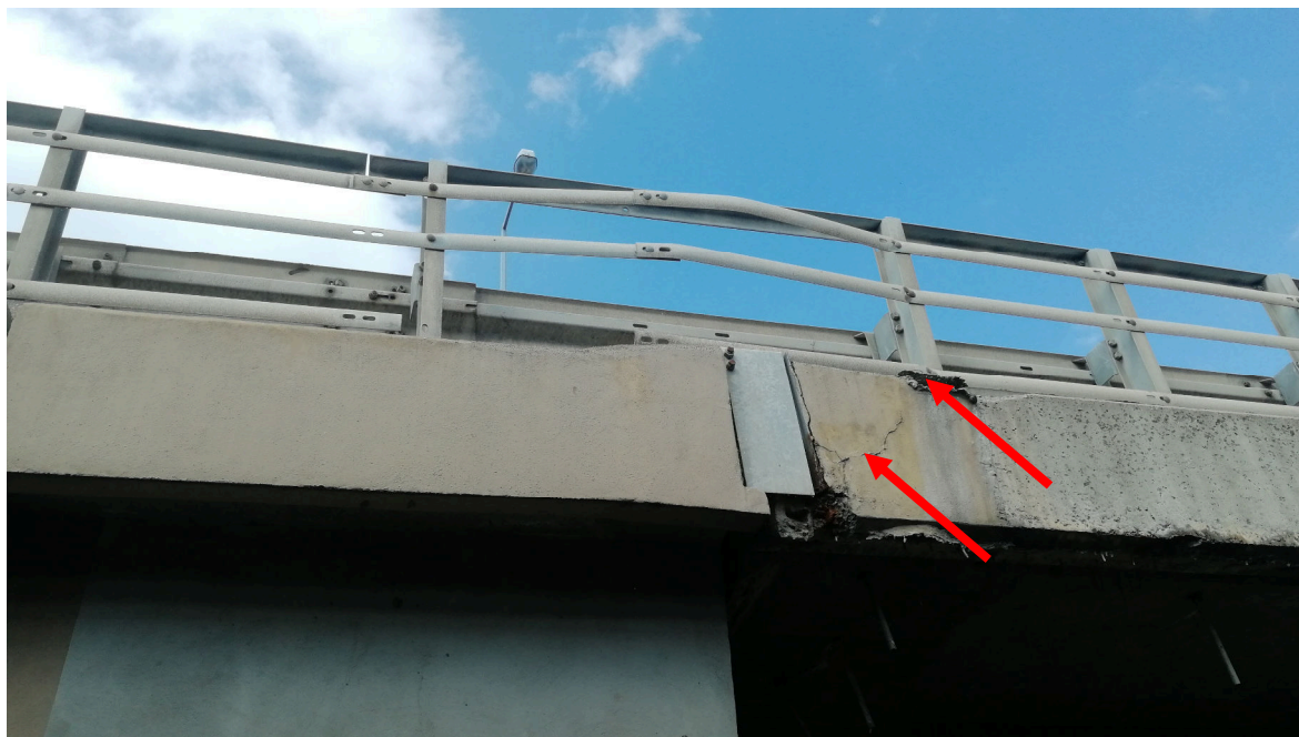
Rys. 5.23. Belka gzymsowa, przyczółek P1N. Widoczne ubytki, odspojenia oraz spękania betonu belki gzymsowej.
