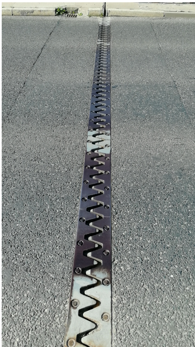
Rys. 4.18. Urządzenie dylatacyjne w obszarze jezdni południowej (przęsło skrajne od strony Zabobrza). Możliwość z realizowania przesuwów w kierunku i od przyczółka. Zamontowana nakładka tłumiąca hałas. Zalegające zanieczyszczenia.
