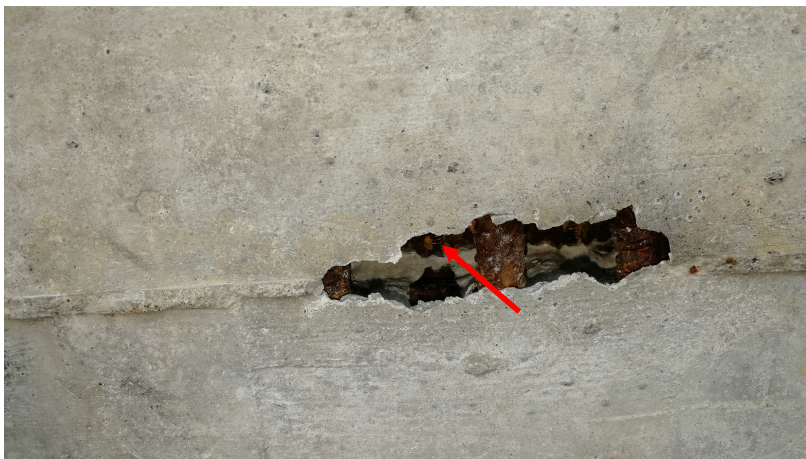
Rys. 4.14. Belka zewnętrzna przęsła skrajnego, raki w płycie dolnej, widoczne odsłonięte pręty zbrojeniowe oraz osłona kabla sprężającego. Korozja powierzchniowa zbrojenia oraz osłony.
