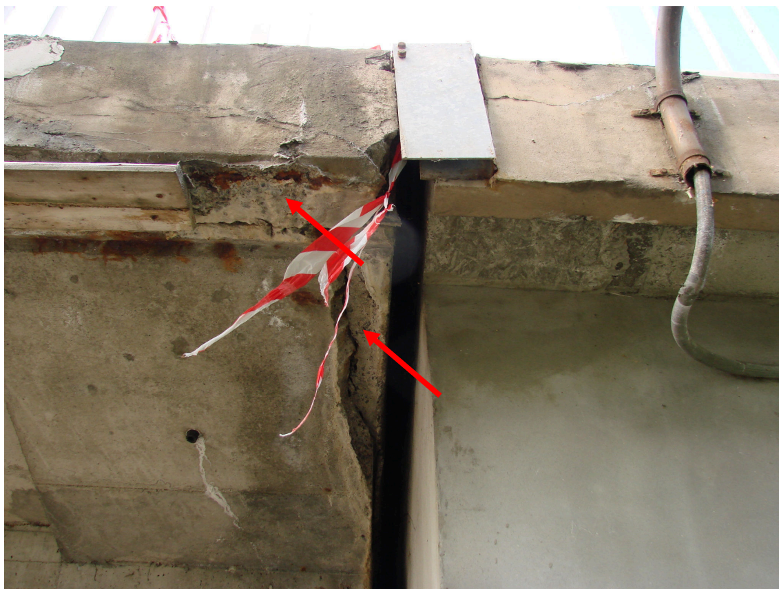
Rys. 4.15. Płyta pomostowa wspornika chodnikowego. Przęsło skrajne od strony Zabobrza (przyczółek P14S). Widoczne pęknięcia betonu konstrukcyjnego, odspojenia, zacieki węglanu wapnia, odsłonięcie prętów zbrojeniowych oraz ich korozja.
