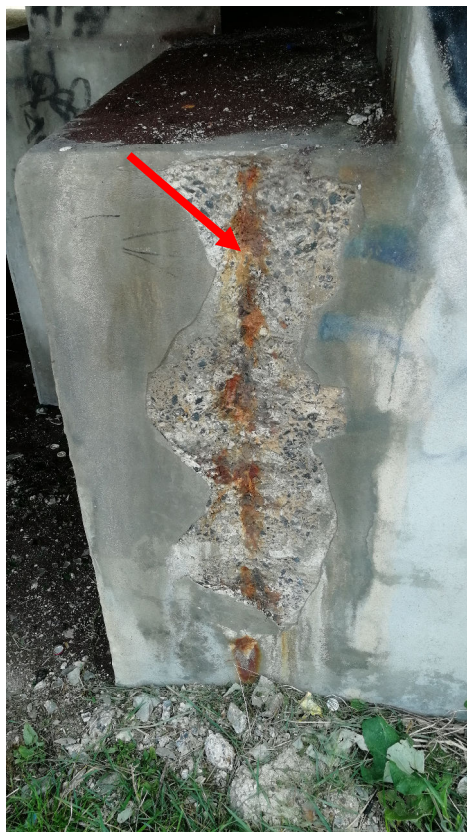
Rys. 5.2. Widok z boku (od strony północnej) korpusu przyczółka P1N. Widocznie odspojenia betonu, odkryte i skorodowane zbrojenie.
