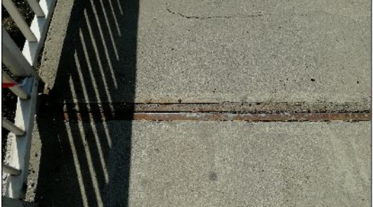
Zaciśnięcie urządzenia dylatacyjnego w strefach chodnikowych.
