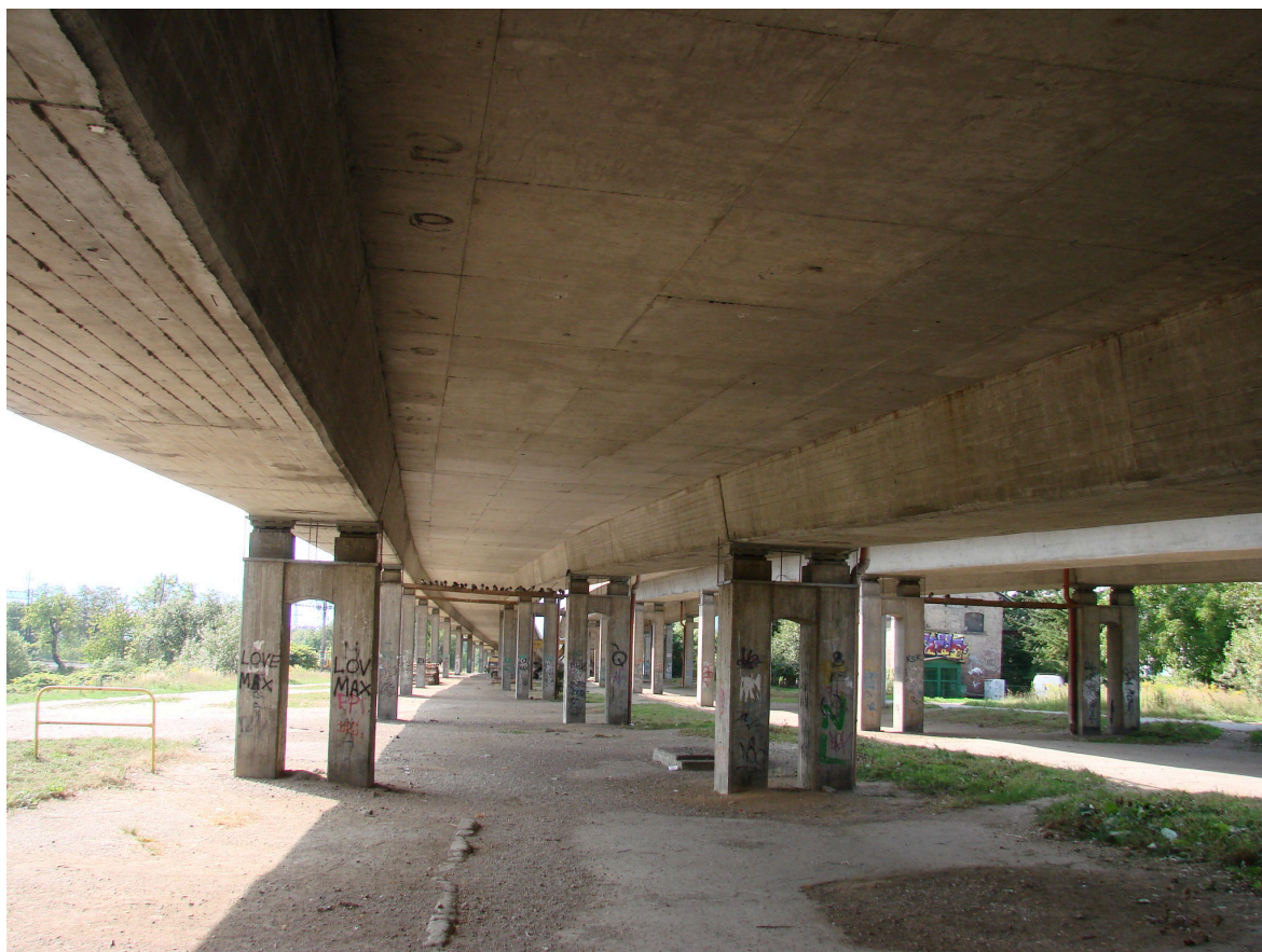
Rys. 4.5. Widok ogólny na słupy podpory pośredniej P13S. Widocznie zanieczyszczenia powierzchni oraz pokrycie graffiti.
