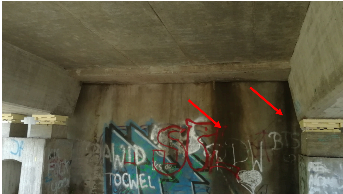
Rys. 4.1. Widok ściany czołowej przyczółka P1S. Widocznie zacieki i zanieczyszczenie powierzchni. Stwierdzono zawilgocenie oraz przenikanie wody przez nieszczelne urządzenie dylatacyjne.
