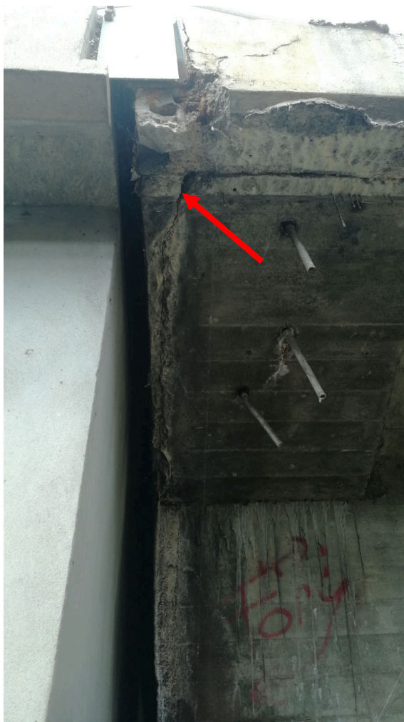
Rys. 5.15. Płyta pomostowa wspornika chodnikowego. Przęsło skrajne od strony Centrum Jeleniej Góry (przyczółek P1N). Widoczne pęknięcia betonu konstrukcyjnego, odspojenia, zacieki węglanu wapnia, odsłonięcie prętów zbrojeniowych oraz ich korozja.
