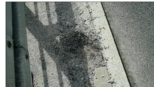
Odspojenia i pęcznienie nawierzchni chodnika. Destrukcja betonu kapy chodnikowej. Ubytki, odspojenia i nieuszczelności na styku z krawężnikiem.
