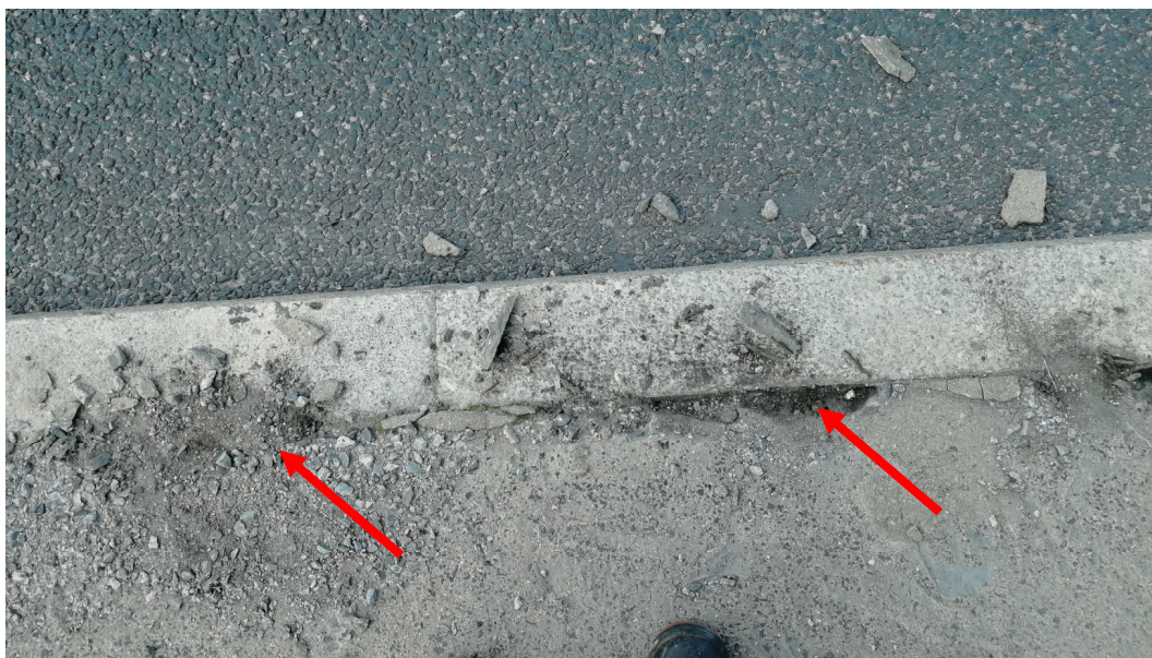
Rys. 5.21. Kapa na styku krawężnika w obszarze pasa rozdziału. Widoczne wykruszenia betonu, luźny materiał.
