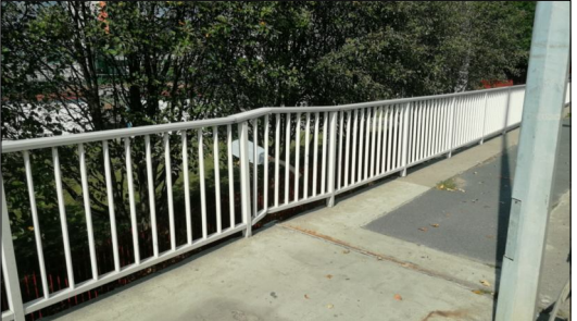
Deformacja balustrady aluminiowej.
