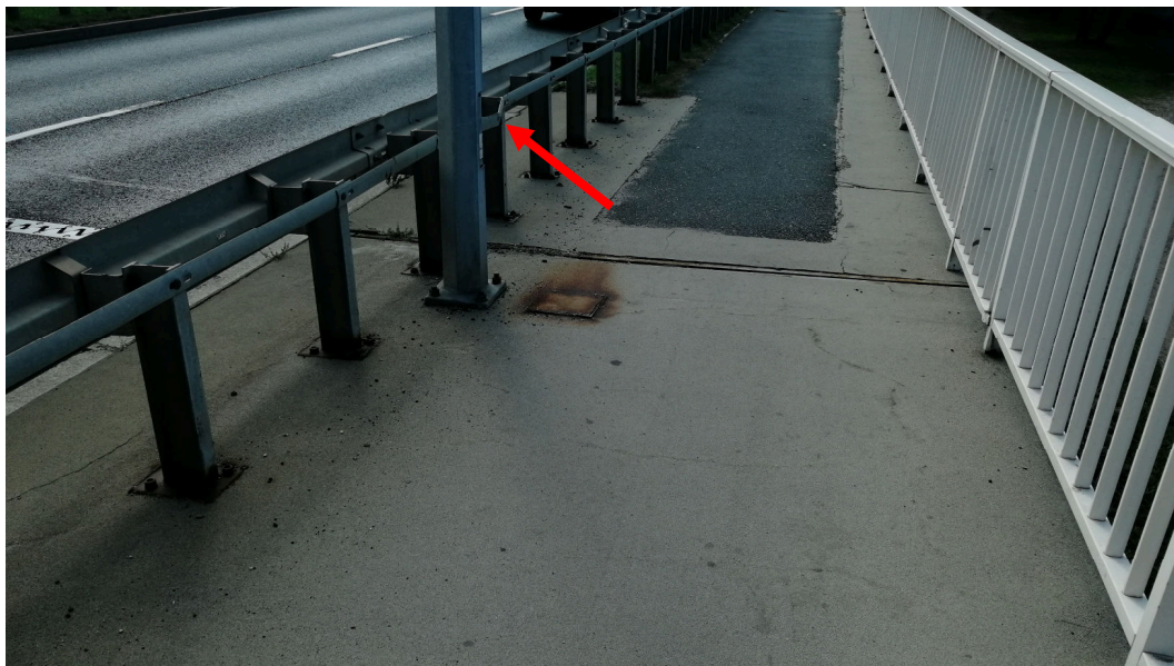
Rys. 5.27. Bariera ochronna, przęsło skrajne od strony centrum Jeleniej Góry. Widoczne deformacje elementów bariery, spowodowane brakiem swobody przemieszczeń na styku przęsło/przyczółek.
