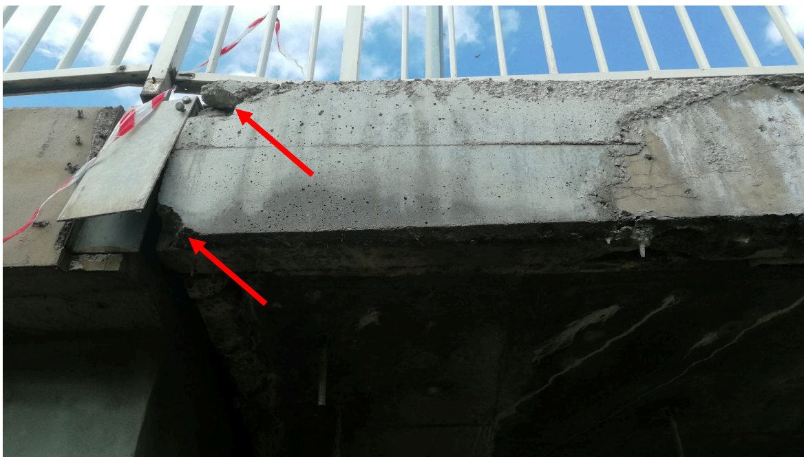
Rys. 4.24. Belka gzymsowa, przyczółek P1S. Widoczne ubytki oraz odspojenia betonu.
