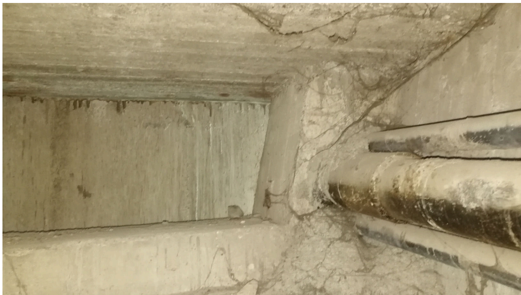
Rys. 4.13. Belka przęsła skrajnego, widok w strefie wewnętrznej w obszarze oparcia na podporze P14S. Kable sprężające przy przeponie skrajnej. Brak widocznych uszkodzeń w tej strefie.
