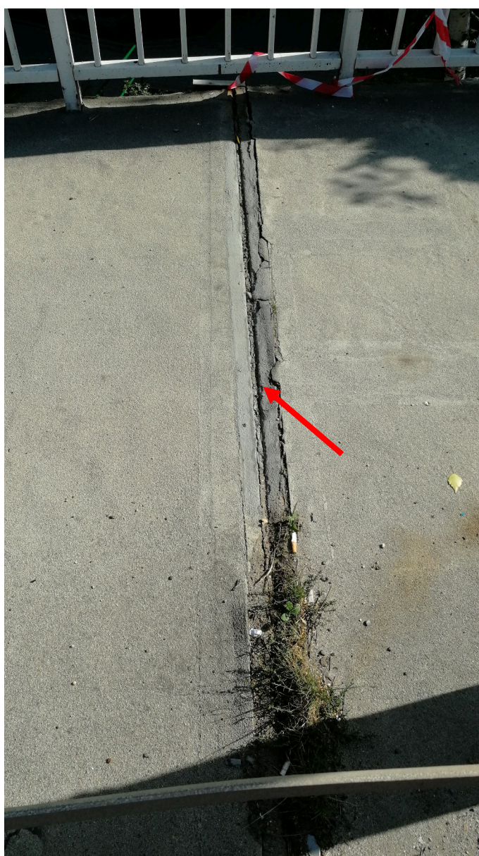
Rys. 4.17. Urządzenie dylatacyjne w obszarze chodnika. Przeszło skrajne od strony Zabobrza (przyczółek P14S). Widoczne całkowite zamknięcie urządzenie dylatacyjne. Brak możliwości realizowania przesuwów w kierunku przyczółka 14S. Zalegające zanieczyszczenia, wegetacja roślin.
