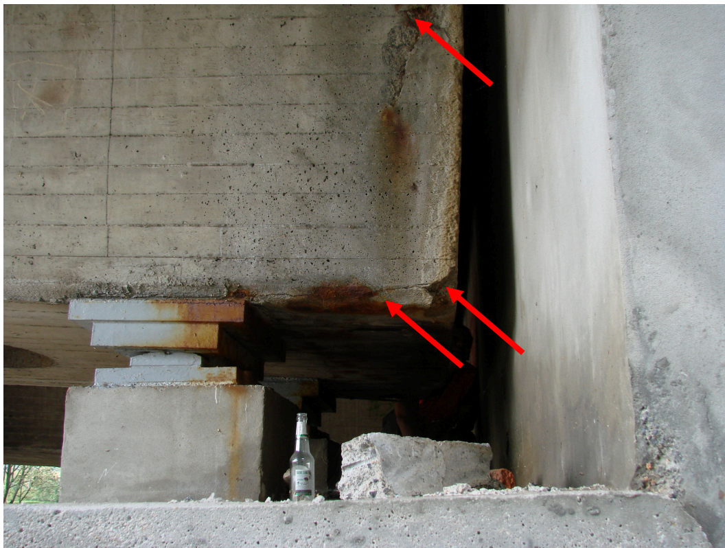
Rys. 4.9. Belka zewnętrzna przeszła skrajnego, widok w strefie oparcia na przyczółku 14S. Zaawansowana korozja betonu, odspojenia, uszkodzenia krawędzi, nacieki węglanu wapnia.
