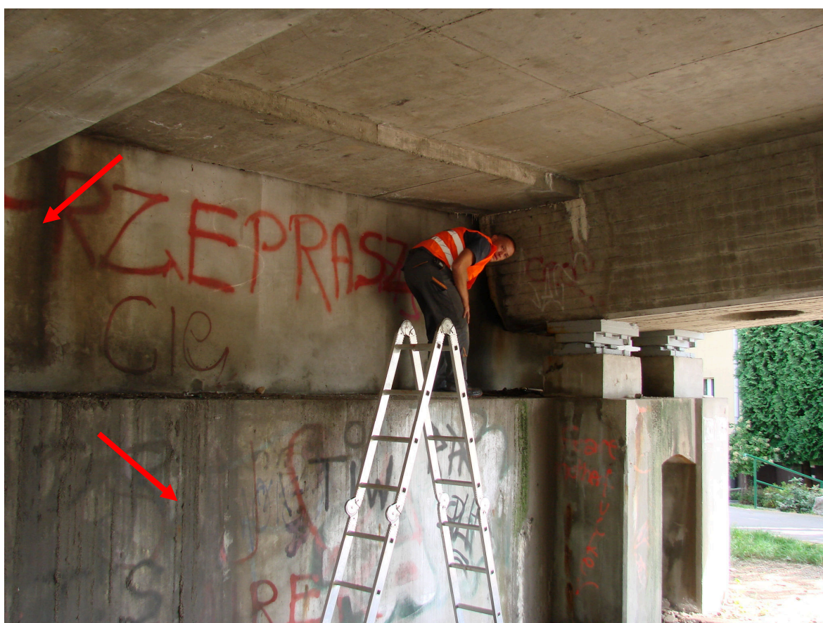
Rys. 4.3. Widok niszy podłożyskowej przyczółka P14S oraz strefy oparcia dźwigara zewnętrznego. Widocznie zacieki i zanieczyszczenie powierzchni. Stwierdzono zawilgocenie oraz przenikanie wody przez nieszczelne urządzenie dylatacyjne. Lokalne ubytki betonu.
