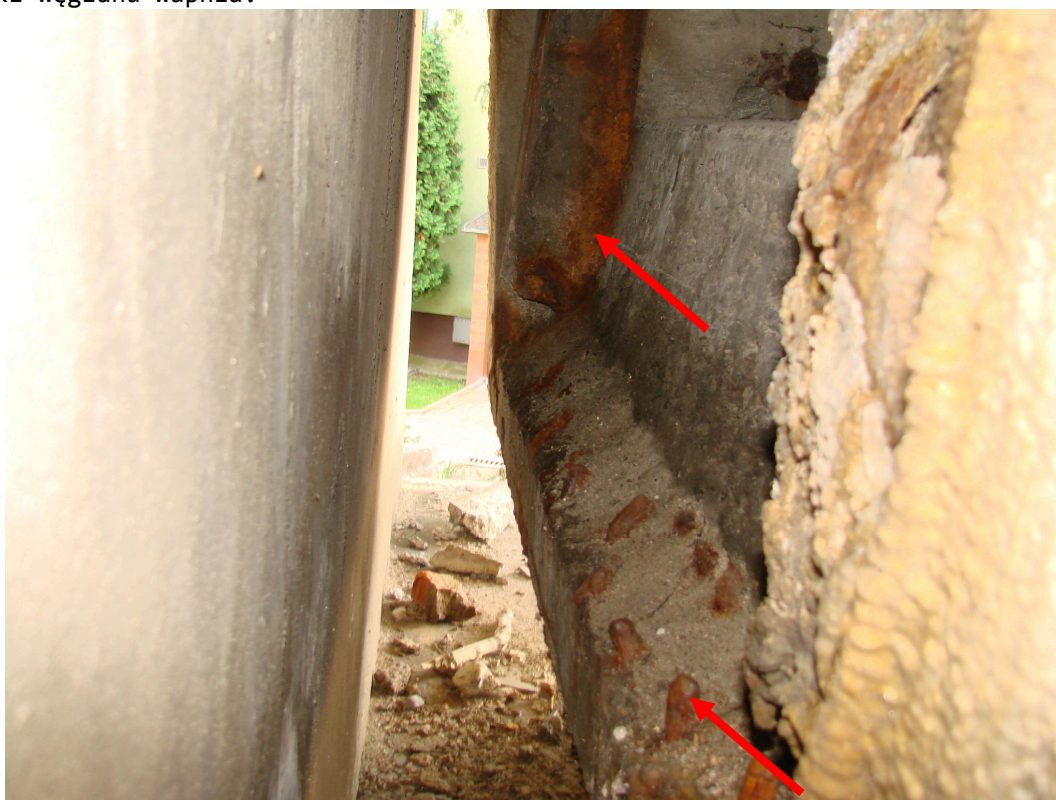
Rys. 4.10. Belka zewnętrzna przeszła skrajnego, widok w strefie zakończenia belki na przyczółku 14S. Korozja zbrojenia, korozja betonu i jego odspojenia, uszkodzenia krawędzi, rdzawe nacieki w strefie zakotwień kabli sprężających.
