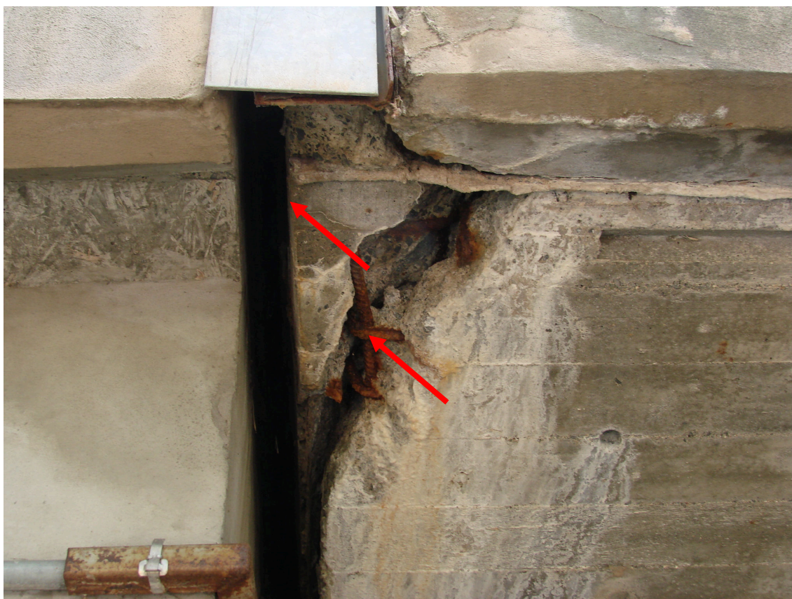
Rys. 5.14. Płyta pomostowa wspornika chodnikowego. Przęsło skrajne od strony Zabobrza (przyczółek P14N). Widoczne pęknięcia betonu konstrukcyjnego, odspojenia, zacieki węglanu wapnia, odsłonięcie prętów zbrojeniowych oraz ich korozja.
