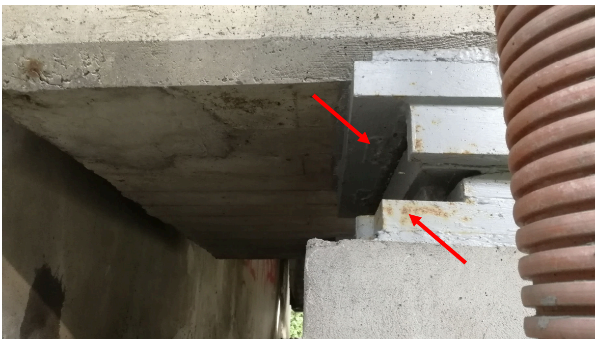
Rys. 4.7. Widok ogólny łożyska na przyczółku P14S, strefa oparcia dźwigara wewnętrznego. Brak opórek/ograniczników na płycie górnej. Wyraźne wysunięcie płyty górnej względem dolnej w kierunku łożysk stałych (temperatura otoczenia t \sim 16^{\circ}\text{C} ). Ogniska korozji powierzchniowej na płycie dolnej oraz prowadnicach bocznych.
