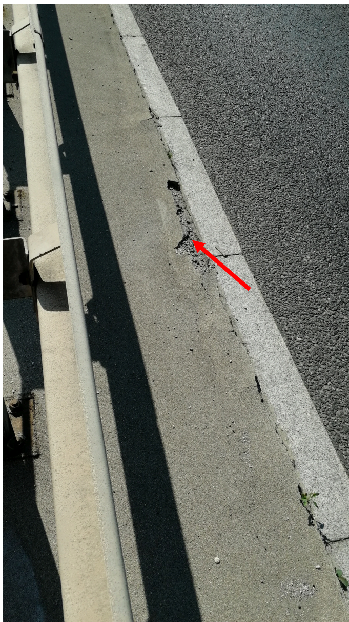
Rys. 4.21. Kapa chodnikowa na styku z krawężnikiem. Widoczne wykruszenia, odspojenia betonu, uszkodzenia nawierzchni. Podniesienie nawierzchni świadczące o zaawansowanej korozji w głębszej betonu kapy.
