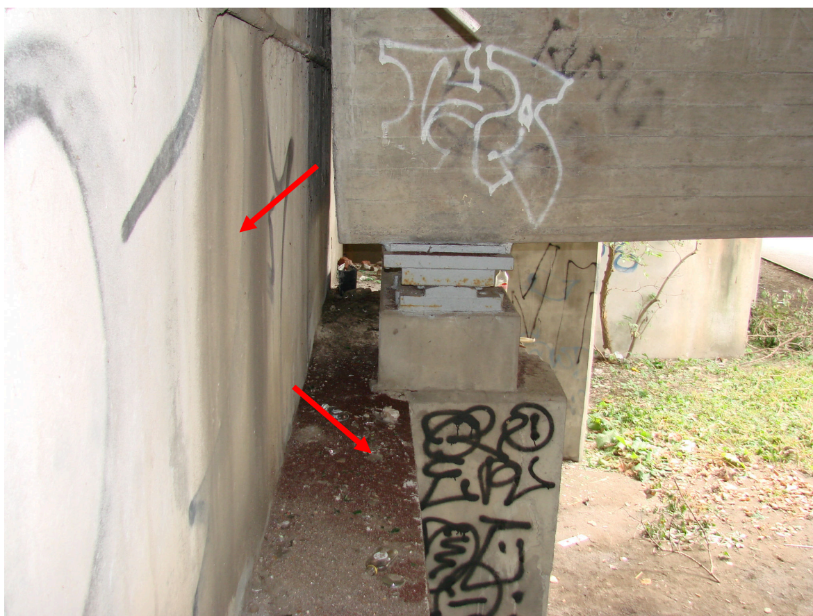
Rys. 5.3. Widok niszy podłożyskowej przyczółka P14N oraz strefy oparcia dźwigara. Widocznie zanieczyszczenie niszy podłożyskowej. Stwierdzono zawilgocenie oraz przenikanie wody przez nieszczelne urządzenie dylatacyjne. Lokalne ubytki betonu.
