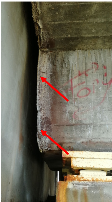
Rys. 5.9. Belka zewnętrzna przeszła skrajnego, widok w strefie oparcia na przyczółku 1N. Zaawansowana korozja betonu, odspojenia, uszkodzenia krawędzi, nacieki węglanu wapnia.
