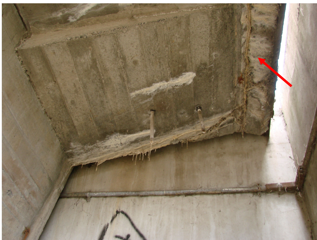
Rys. 5.24. Belka gzymsowa przy pasie rozdziału, przyczółek P14N. Widoczna zaawansowana korozja betonu, nacieki węgla wapnia.
