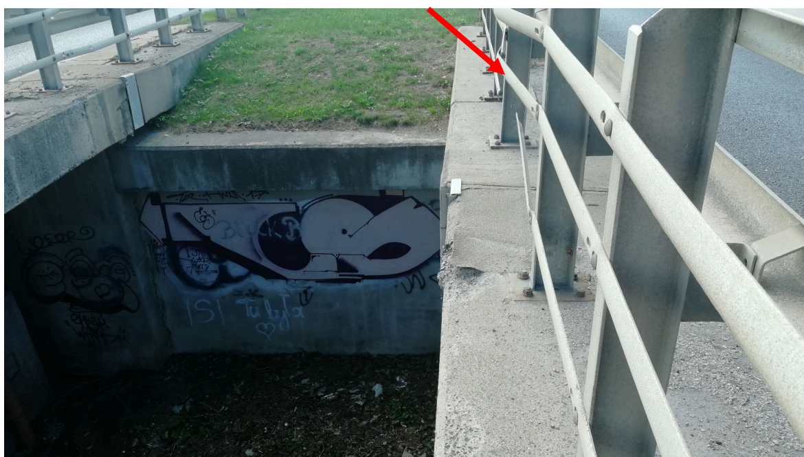
Rys. 5.26. Barieroporęcz, przęsło skrajne od strony centrum Jeleniej Góry. Widoczne deformacje elementów bariery spowodowane brakiem swobody przemieszczeń na styku przęsło/przyczółek.
