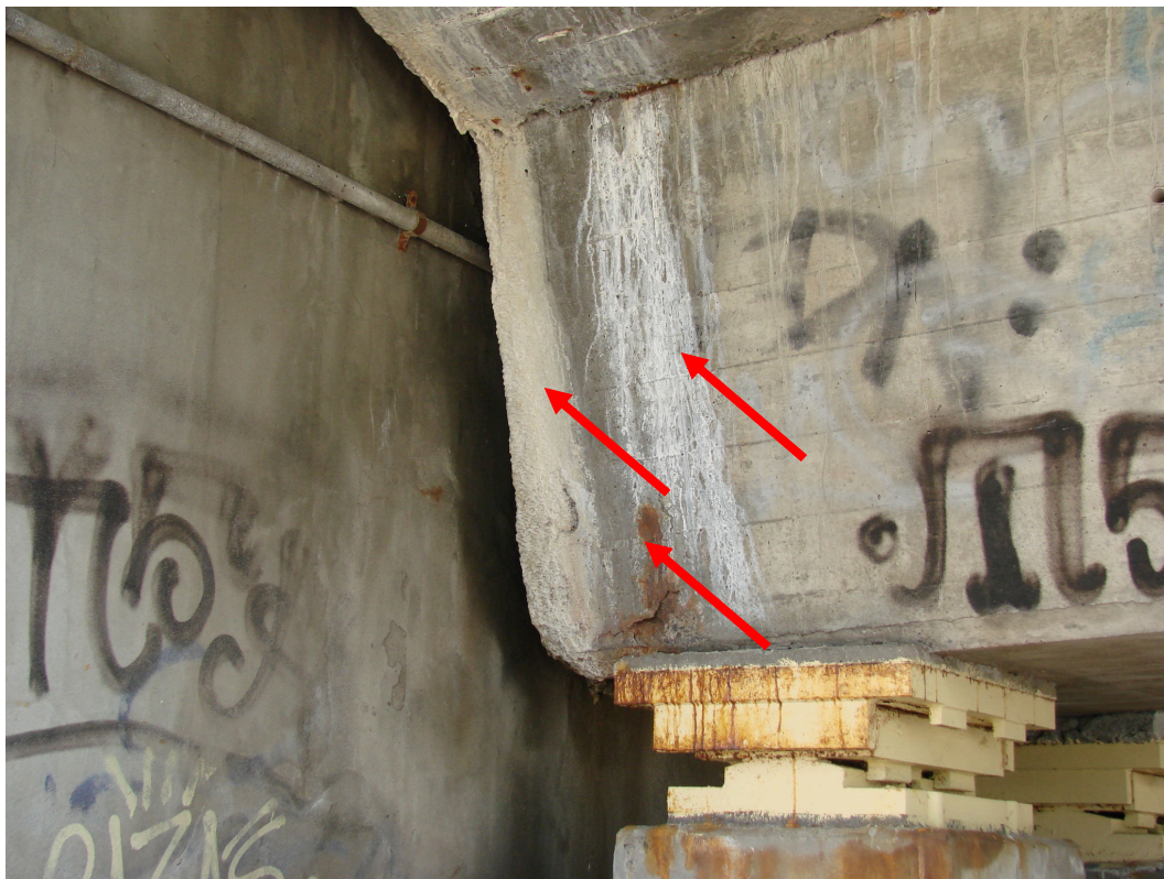
Rys. 5.11. Belka zewnętrzna przeszła skrajnego, widok w strefie zakończenia belki na przyczółku 1N. Korozja zbrojenia, korozja betonu i jego odspojenia, uszkodzenia krawędzi.
