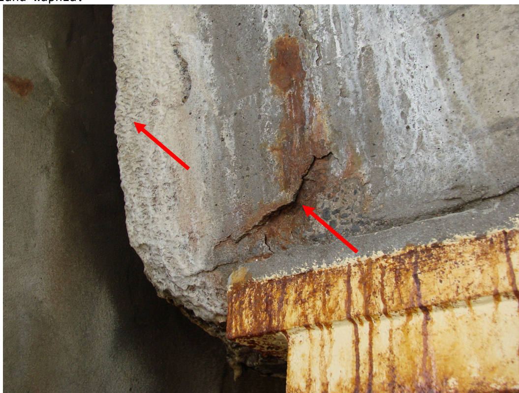
Rys. 5.10. Belka zewnętrzna przeszła skrajnego, widok w strefie zakończenia belki na przyczółku 1N. Korozja zbrojenia, korozja betonu i jego odspojenia, uszkodzenia krawędzi.
