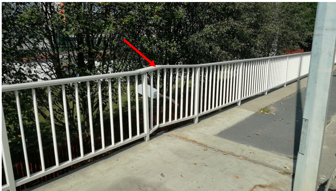
Rys. 5.25. Balustrada przy chodniku, przęsło skrajne od strony Zabobrza. Widoczne deformacje elementów balustrady, spowodowane brakiem swobody przemieszczeń na styku przęsło/przyczółek (zamknięte urządzenie dylatacyjne w obszarze chodnika).
