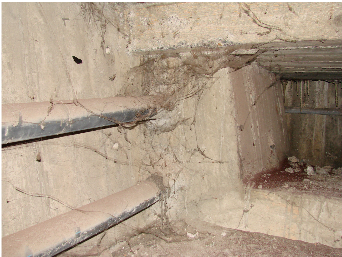
Rys. 5.13. Belka przęsła skrajnego, widok w strefie wewnętrznej w obszarze oparcia na podporze P14N. Kable sprężające przy przeponie skrajnej. Brak widocznych uszkodzeń w tej strefie.
