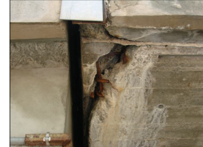
Korozja pęczniąca zbrojenia w strefach podchodnikowych. Odspojenie betonu w strefach podchodnikowych.
