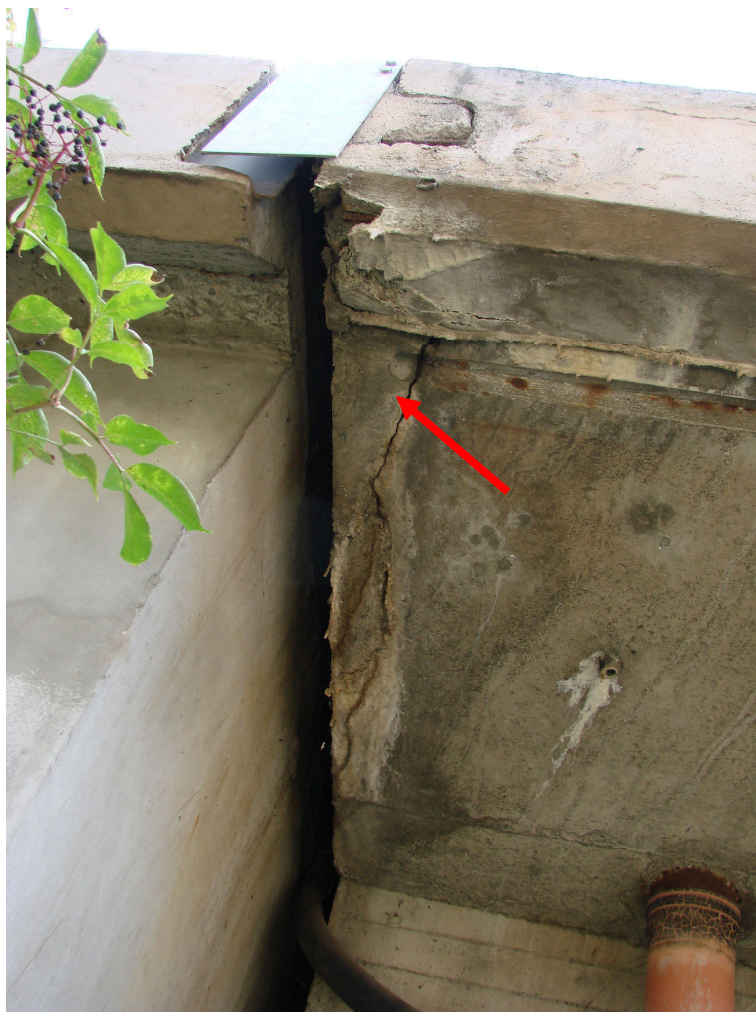
Rys. 4.16. Płyta pomostowa wspornika chodnikowego. Przęsło skrajne od strony Centrum Jeleniej Góry (przyczółek P1S). Widoczne pęknięcia betonu konstrukcyjnego, odspojenia, zacieki węglanu wapnia, odsłonięcie prętów zbrojeniowych oraz ich korozja.
