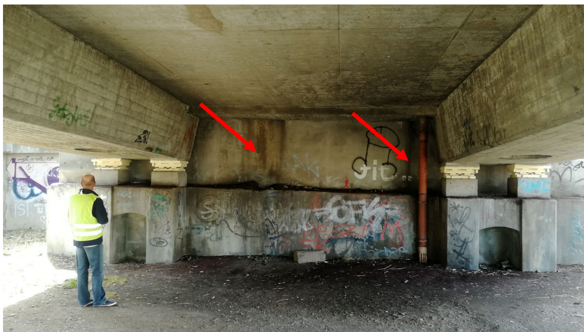
Rys. 5.1. Widok ściany czołowej przyczółka P1N. Widocznie zacieki i zanieczyszczenie powierzchni. Stwierdzono zawilgocenie oraz przenikanie wody przez nieuszczelnione urządzenie dylatacyjne.
