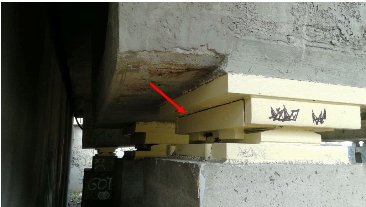
Rys. 4.6. Widok ogólny łożysk na przyczółku P1S, strefa oparcia dźwigara zewnętrznego. Brak opórek/ograniczników na płycie górnej. Wyraźne wysunięcie płyty górnej względem dolnej w kierunku łożysk stałych (temperatura otoczenia t \sim 16^{\circ}\text{C} ).
