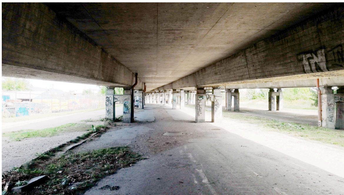
Rys. 5.5. Widok ogólny na słupy podpory pośredniej P2N. Widocznie zanieczyszczenia powierzchni oraz pokrycie graffiti.
