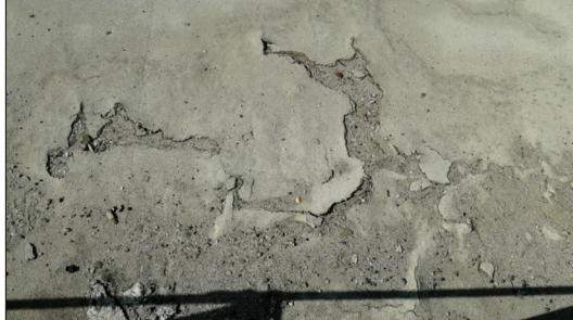
Odspojenia i pęcznienie nawierzchni chodnika.
