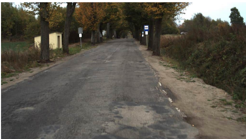
Rysunek 19: Stan zły: liczne uszkodzenia. Nawierzchnia mocno skoleinowana
