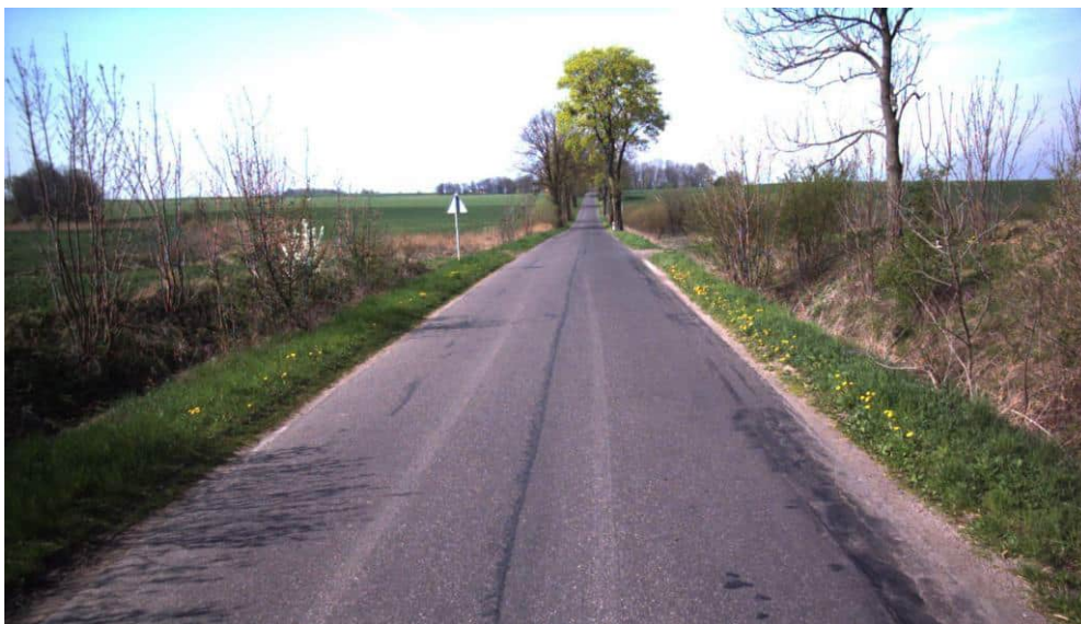
Rysunek 14: Stan ostrzegawczy: łaty nałożone oraz spękania zajmujące do 30% powierzchni
