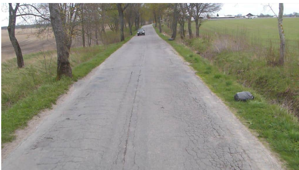
Rysunek 17: Stan zły: spękania siatkowe zajmujące ponad 30% powierzchni
