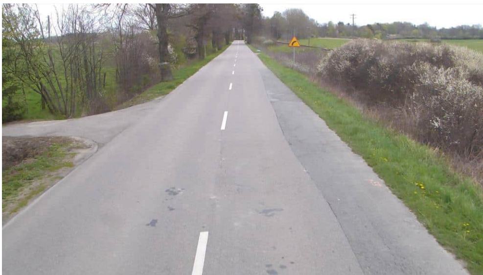
Rysunek 12: Stan ostrzegawczy: łaty wbudowane zajmujące do 30% powierzchni
