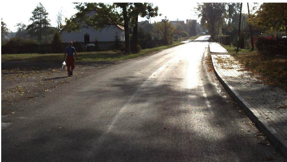
Rysunek 11: Stan ostrzegawczy: brak uszkodzeń powierzchniowych, widoczna nierówność w śladzie prawego koła
