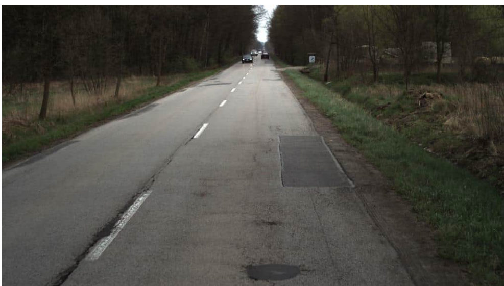
Przykład 2: Niezakodowane nieszczelne spoiny technologiczne na krawędziach łat
