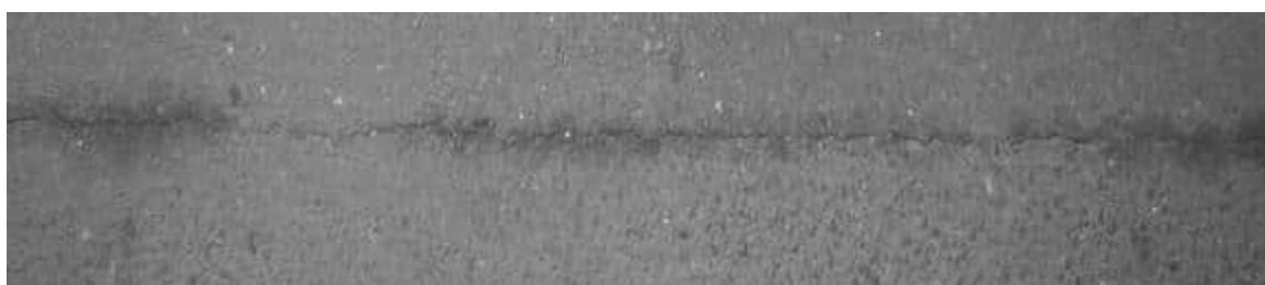
Rysunek 25: Spoiny technologiczne wzdłuż kierunku jazdy widziane na zdjęciu pasa ruchu (fragment)
