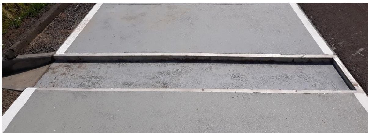
Rys. 5. Zagłębienie na wagi przenośne typu METEOR w kształcie jednostronnie otwartej rynny umożliwiającej grawitacyjny odpływ wody opadowej.
