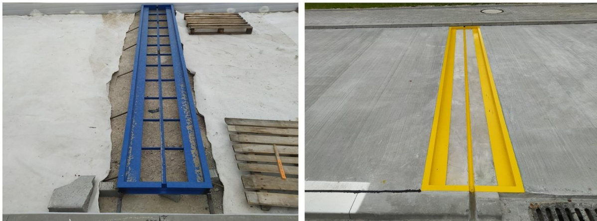
Rys. 6. Gotowa rama montażowa przystosowana do wag przenośnych typu METEOR.
