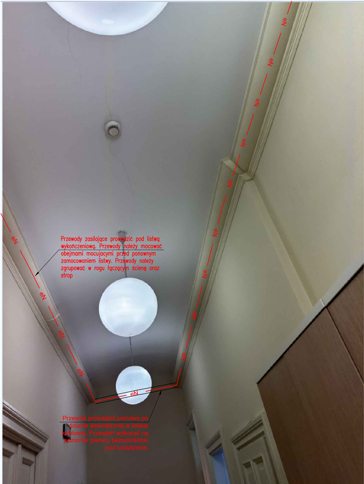
DETAL NR 1. SZCZEGÓŁ WYKONANIE TRASY PRZEWODÓW ELEKTRYCZNYCH POD STROPEM
