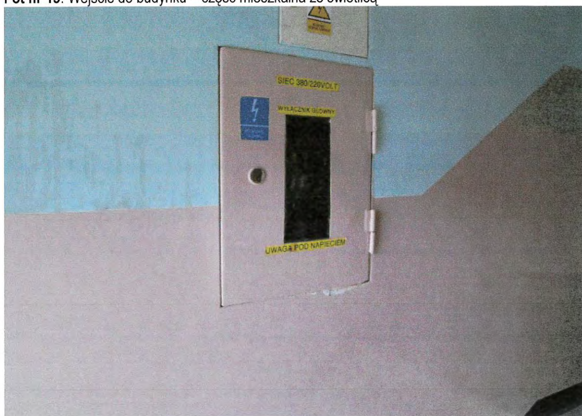
Fot nr 20. Główny wyłącznik prądu przeciwpożarowy (część mieszkalna z salą konferencyjną)
