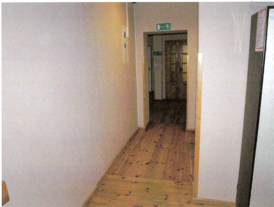
Fot nr 17. Widok zawężenia miejscowego na korytarzu I piętra do wielkości 0,88 m i 1,16 m (część biurowa)
