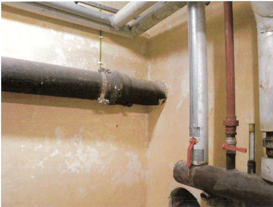
Fot nr 7. Widok ściany wydzielającej kotłownię olejową od składu oleju z niezabezpieczonym przepustem instalacyjnym
