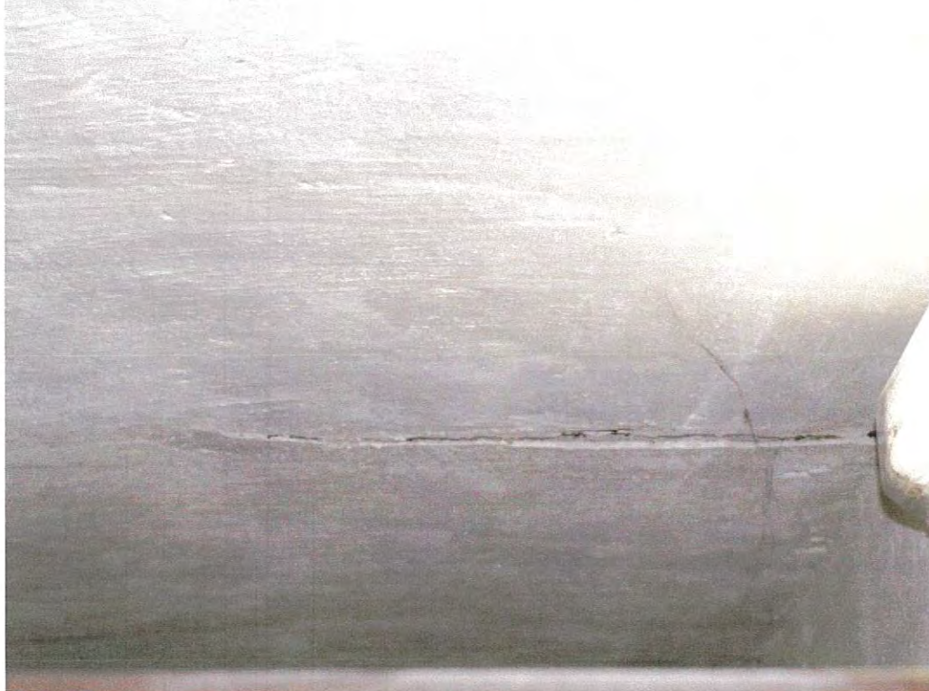
Fot nr 8. Widok stropu z uszkodzoną okładziną, wydzielającego składu oleju opałowego od kondygnacji parteru
