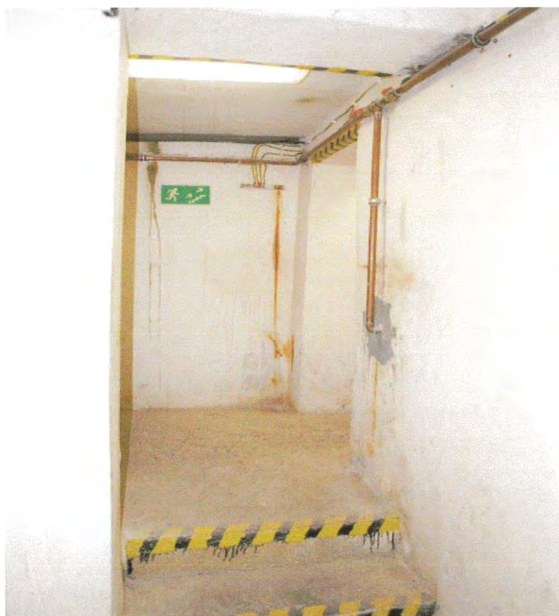
Fot nr 4. Obniżenie miejscowe stropu do wielkości 1,78 m na drodze ewakuacyjnej w piwnicy
