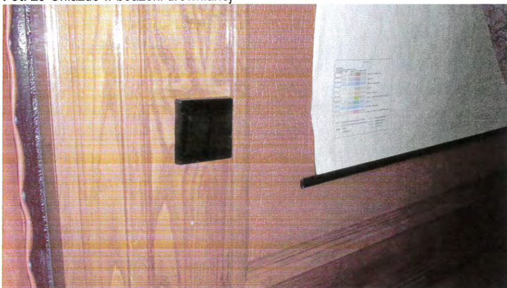
Fot. 30 Wyłącznik w boazerii drewnianej
