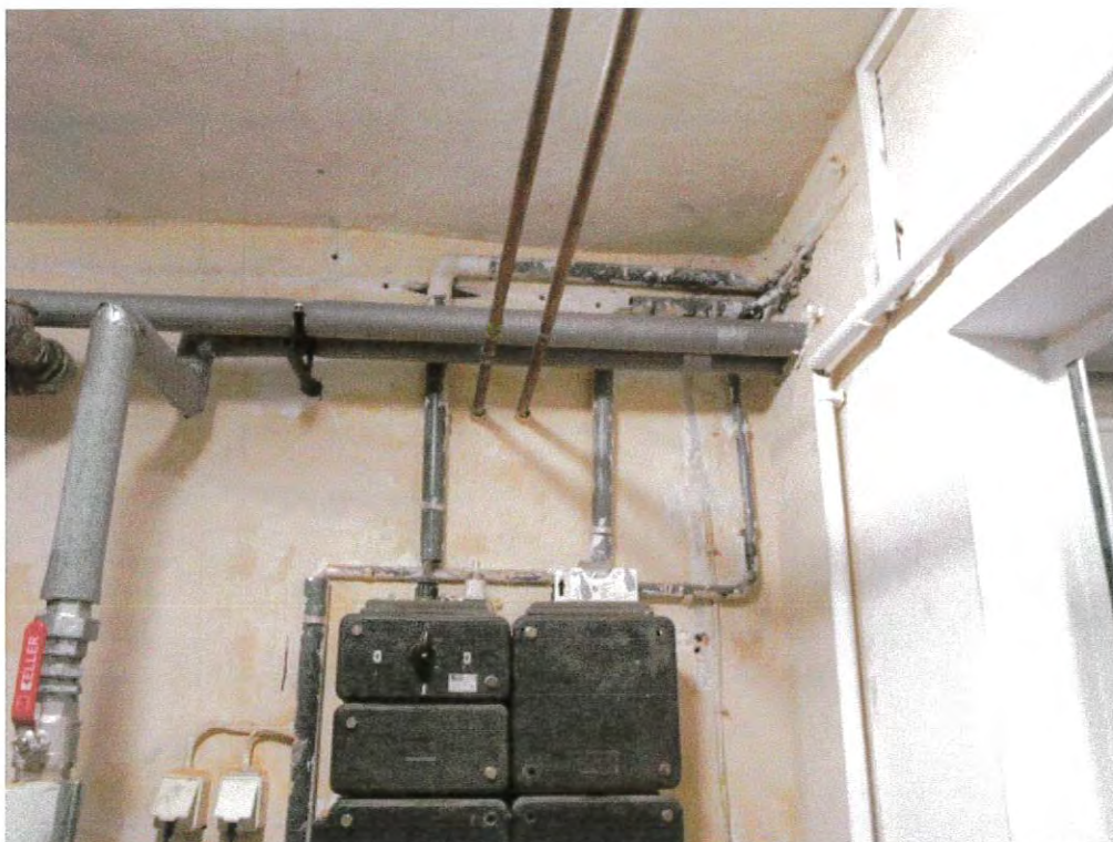
Fot nr 5. Widok ściany wydzielającej kotłownię olejową od korytarza piwnicy z niezabezpieczonymi przepustami instalacyjnymi
