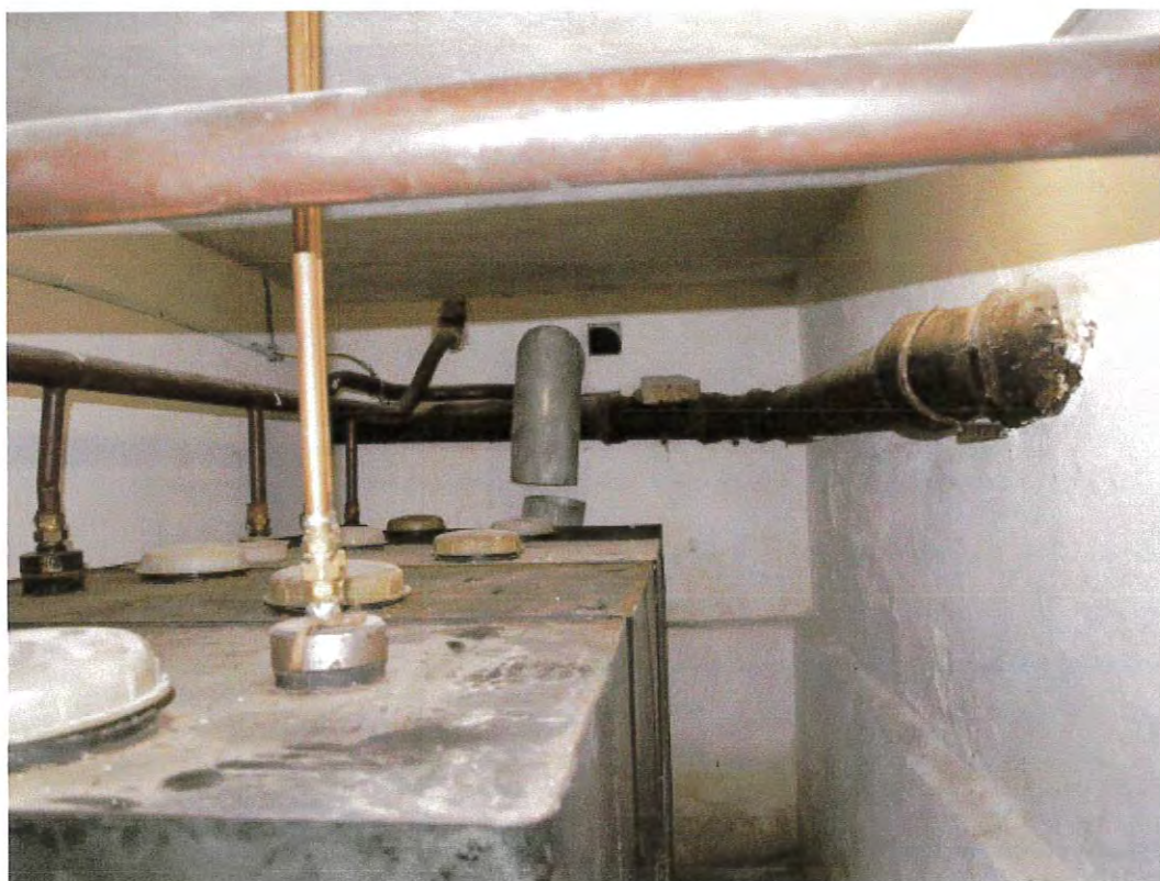
Fot nr 10. Widok zbiornika i uszkodzonego przewodu wentylacyjnego w składzie oleju opałowego
