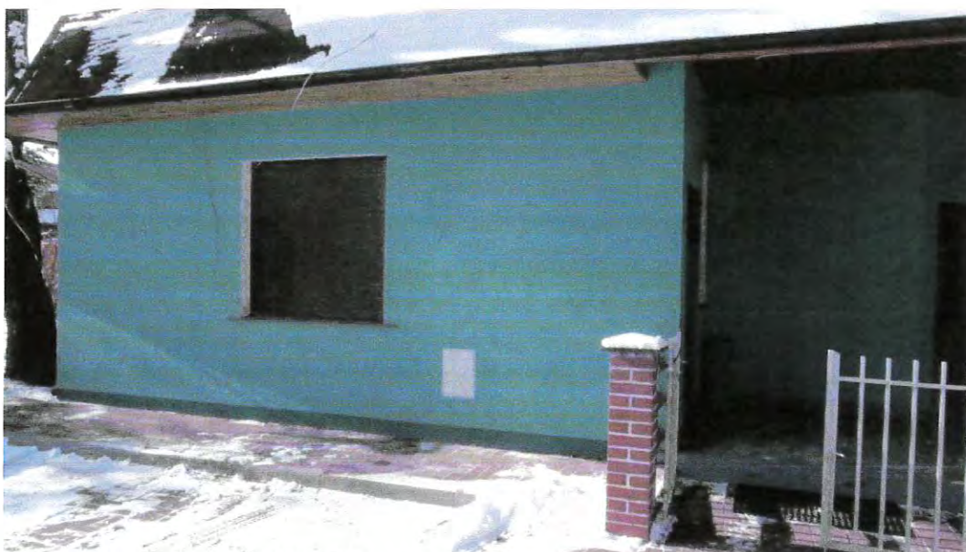
Fot. nr 25 Elewacja wschodnia widok na króciec zlewowy oleju opałowego z obudową szafkową
