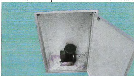
Fot. nr 25 Elewacja wschodnia widok na króciec zlewowy oleju opałowego z obudową szafkową
