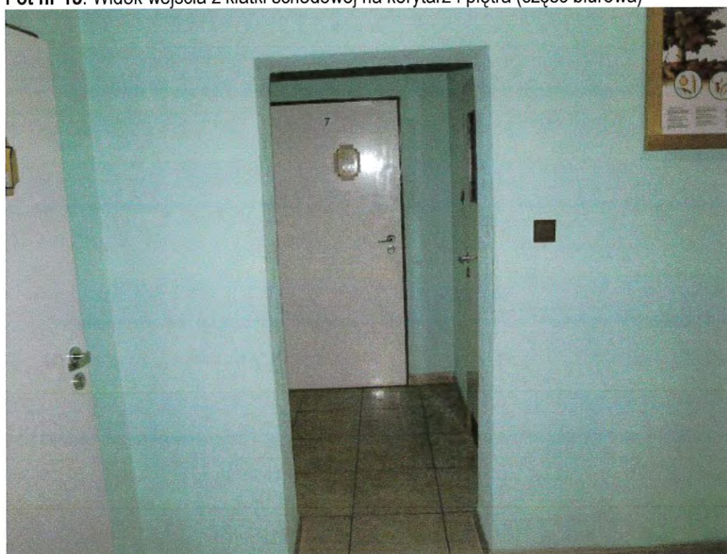
Fot nr 16. Widok zawężenia miejscowego w korytarzu bocznym na parterze do wielkości 0,79 m (część biurowa)
