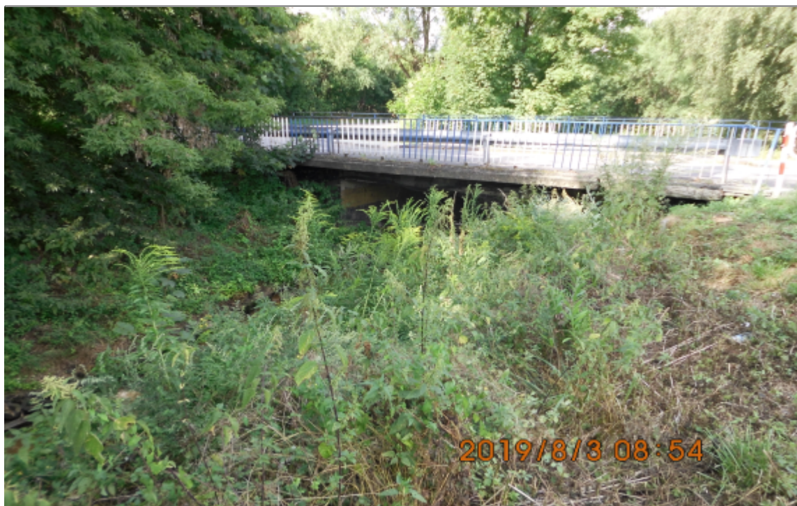
Zdjęcie nr 3.4 : Widok mostu od strony wschodniej
