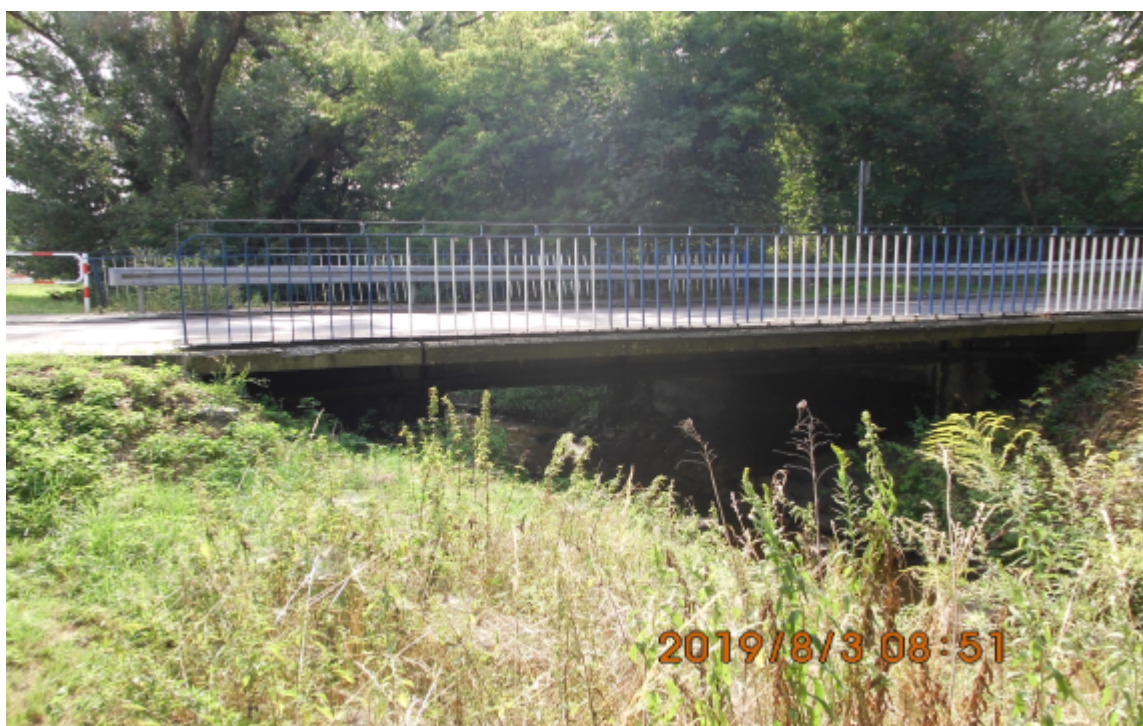
Zdjęcie nr 3.3: Widok mostu od strony zachodniej
