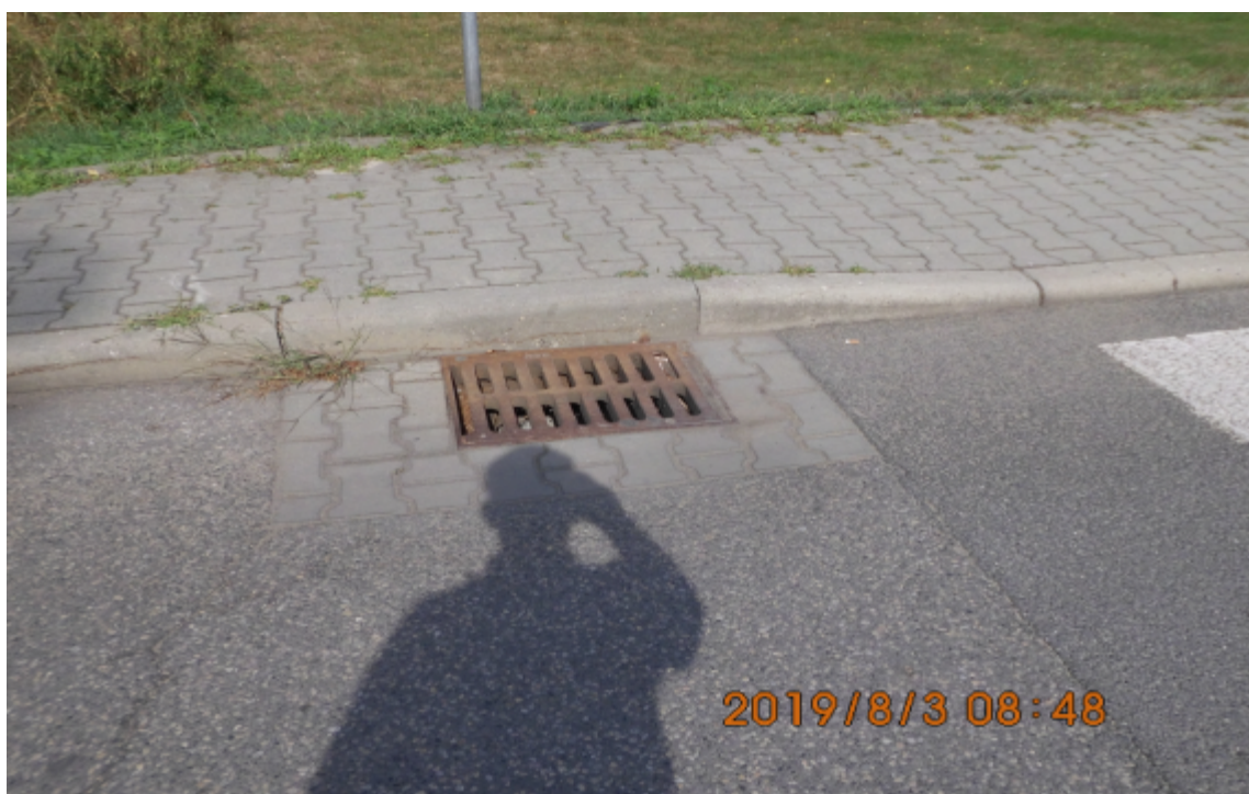
Zdjęcie nr 3.6 : Naprawiono uszkodzenia nawierzchni w rejonie wpustu.
