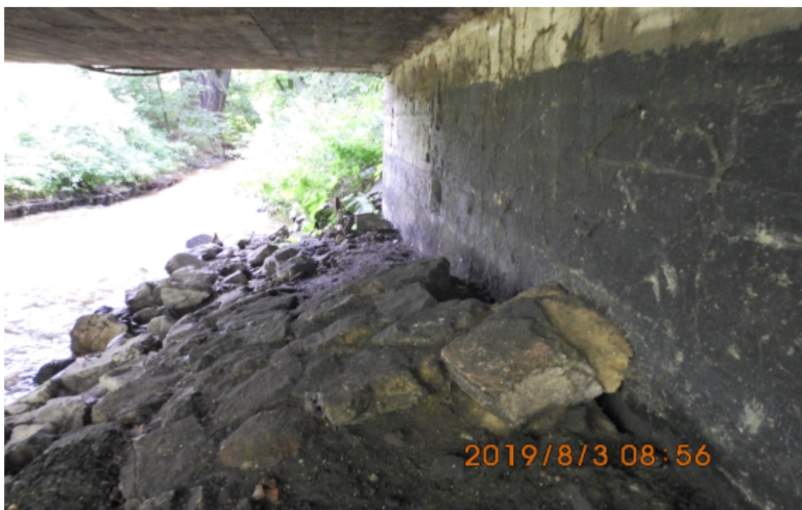
Zdjęcie 3.14 : Naprawić umocnienie skarp . Prawidłowo ochronić urządzenia obce.
